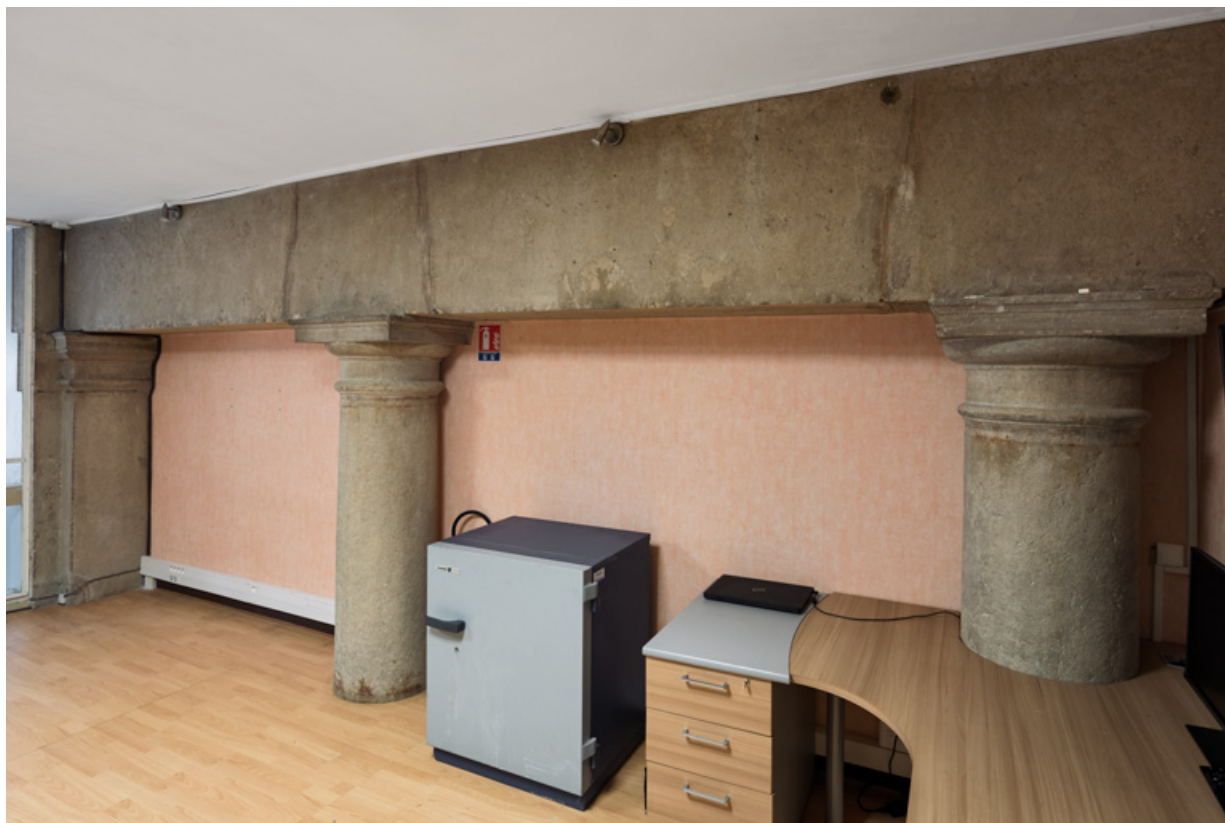
Partie supérieure et chapiteau d'un pilastre et de deux colonnes dans l'ancienne halle. 71, Autun place du Champ de Mars
