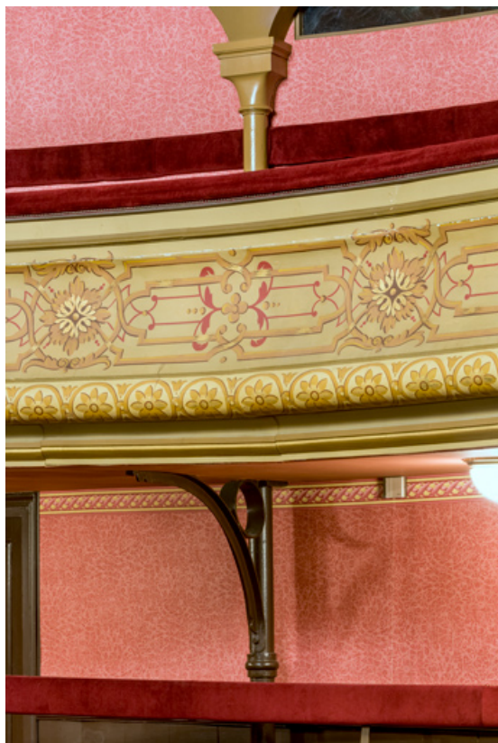
Garde-corps du 3e balcon et poteaux métalliques.
