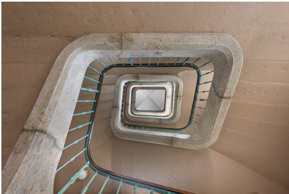
Escalier côté cour, vu en contre-plongée.
