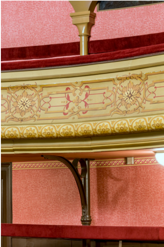
Garde-corps du 3e balcon et poteaux métalliques.
