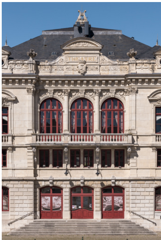
Façade antérieure : travée centrale.
