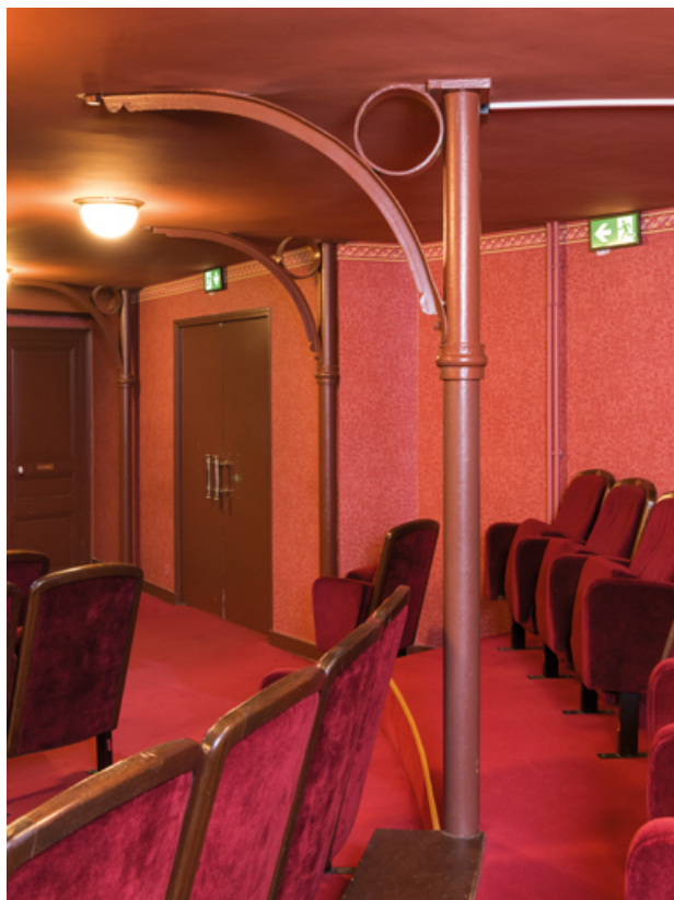
Poteaux métalliques supportant le 1er balcon.
