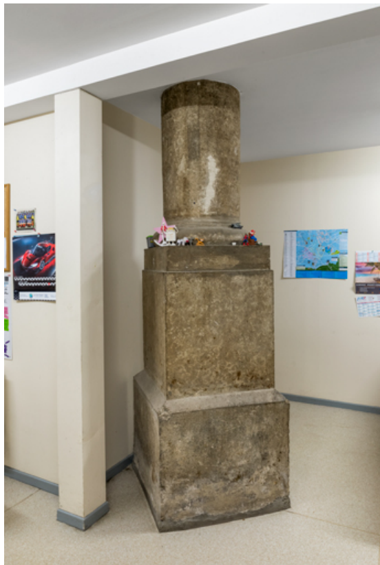
Socle et base d'une colonne dans l'ancienne halle. 71, Autun place du Champ de Mars
