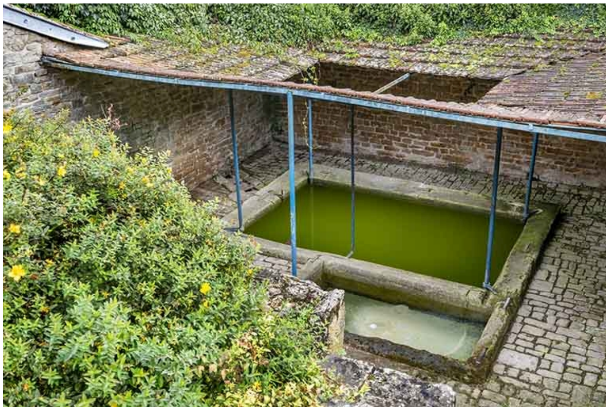
Les deux bassins en vue plongeante depuis la rue.
