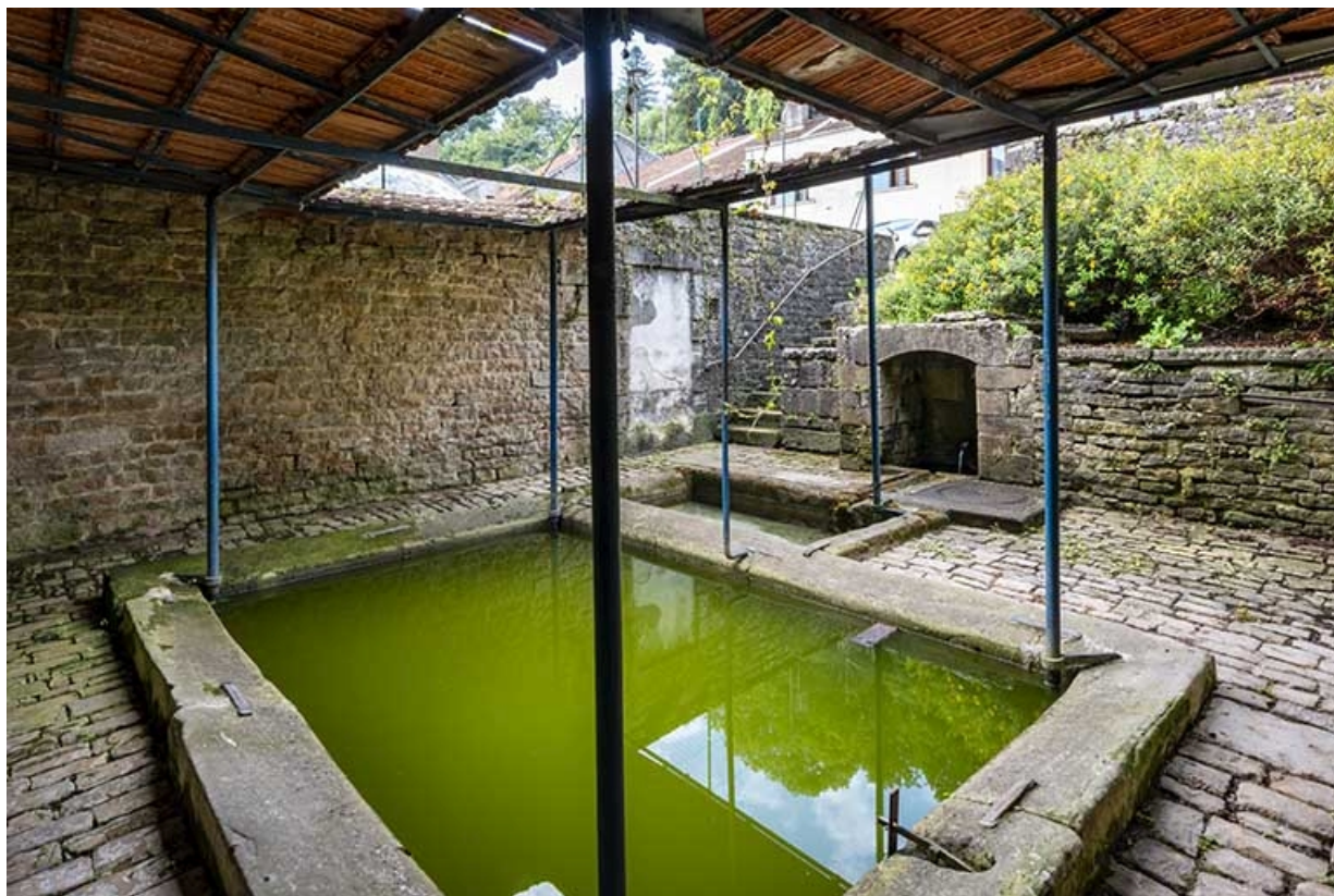
Les deux bassins depuis l'est.
