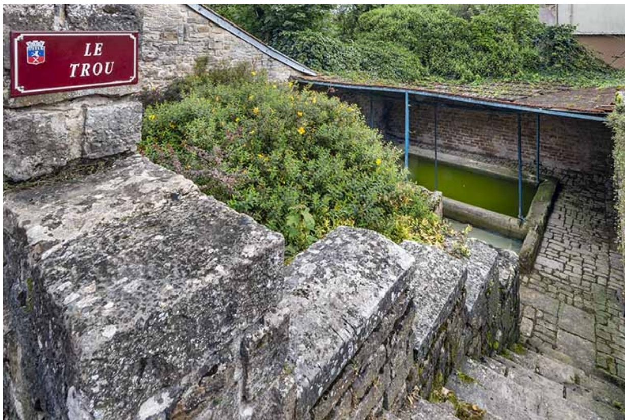
L'escalier et les bassins depuis la rue.
