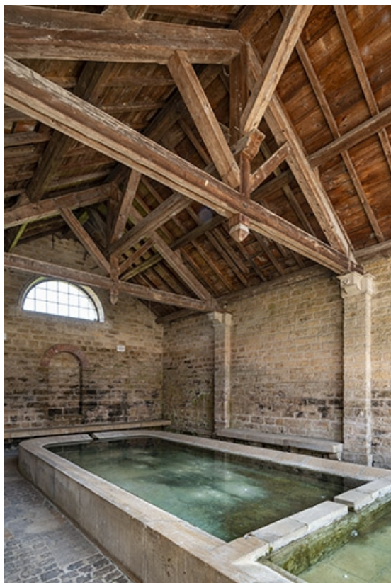
L'intérieur du lavoir, depuis l'entrée.
