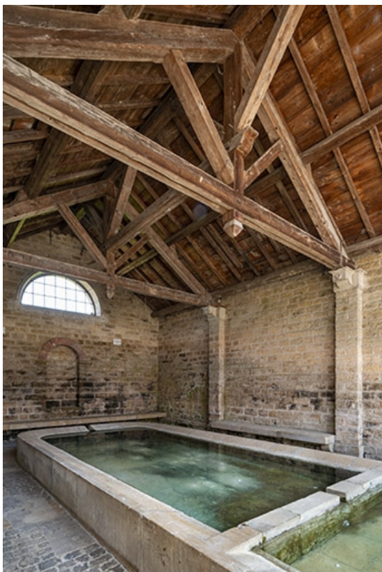
L'intérieur du lavoir, depuis l'entrée.
