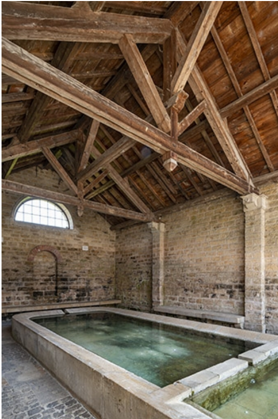
L'intérieur du lavoir, depuis l'entrée.
