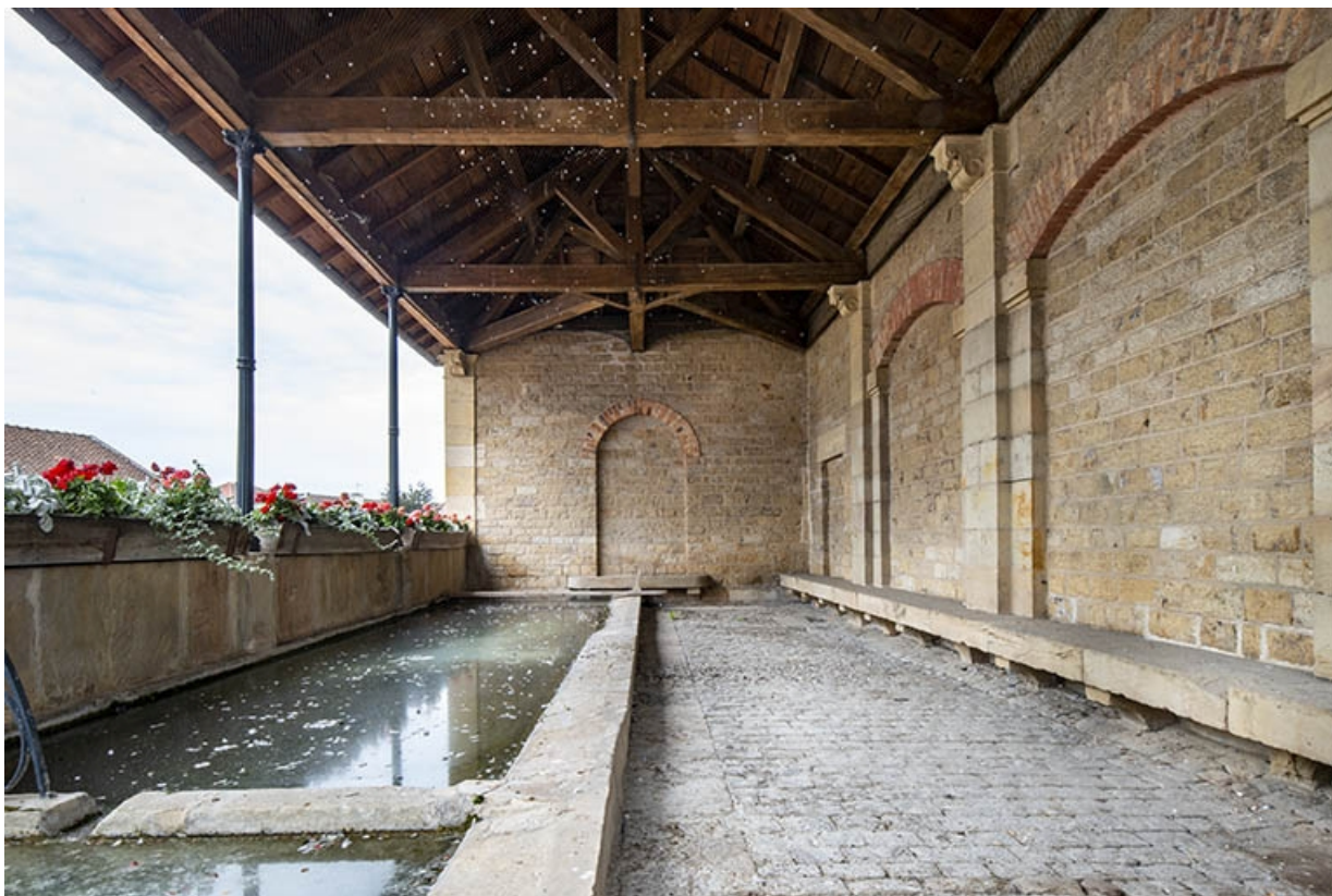
L'intérieur de la fontaine-lavoir, depuis l'entrée.
