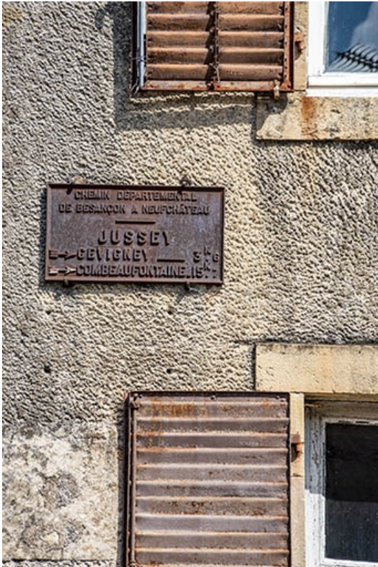
Détail de la façade avec plaque directionnelle.
