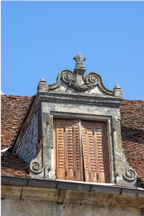
Détail de la lucarne droite.
