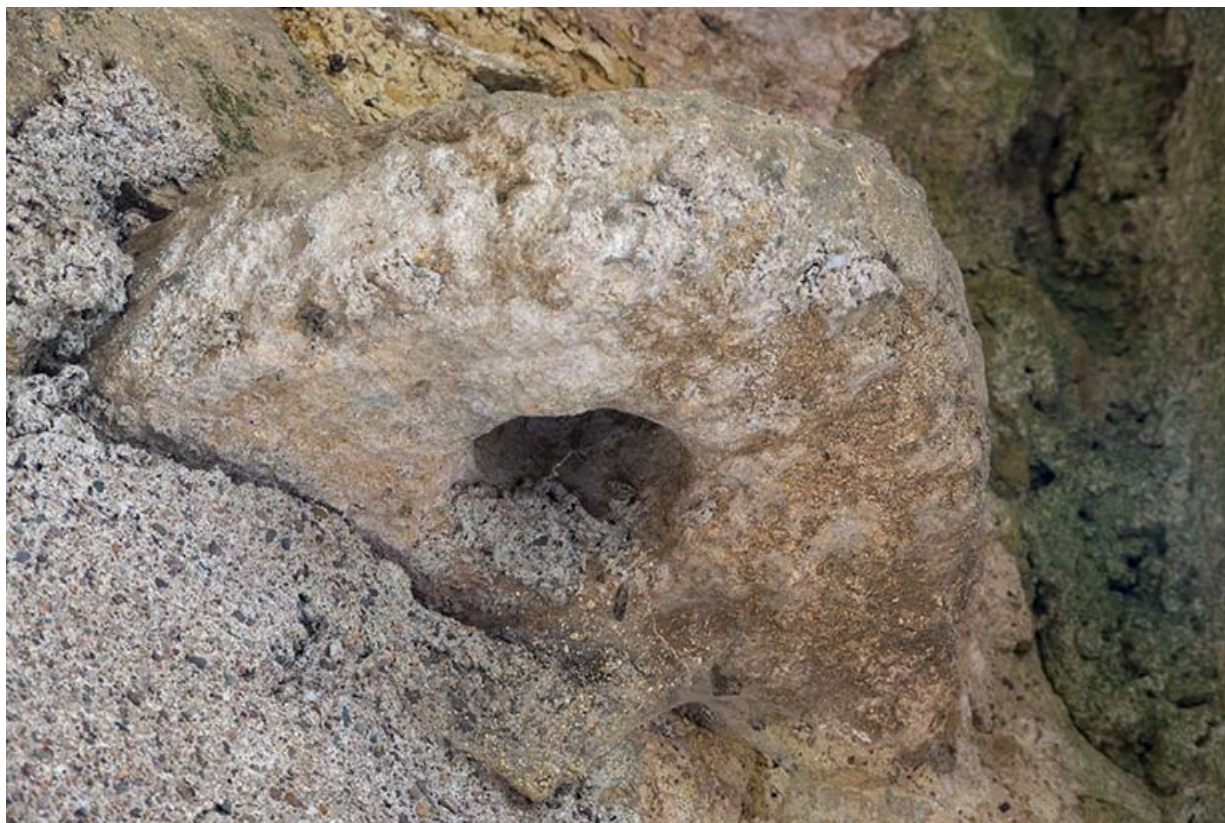
Détail d'un remploi pris dans la maçonnerie.
