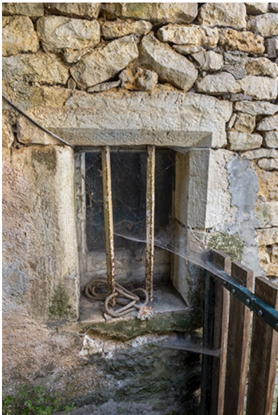
Baie chanfreinée au rez-de-chaussée.
