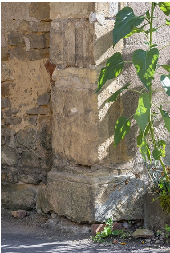
La base du piédroit du portail.
