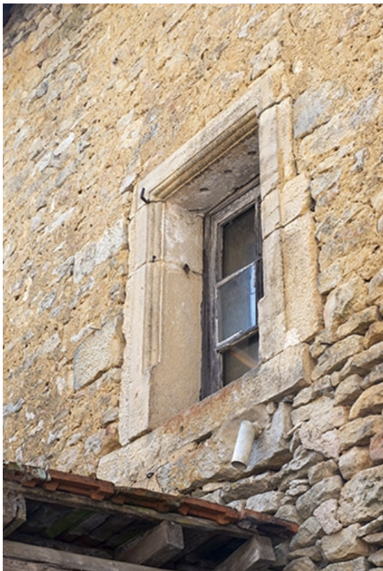
Une baie de l'étage, côté cour.
