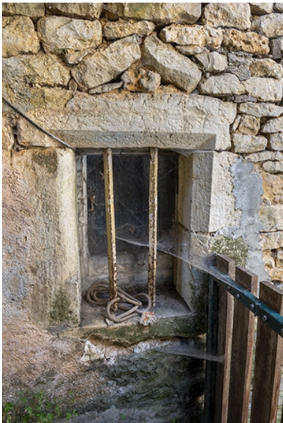
Baie chanfreinée au rez-de-chaussée.
