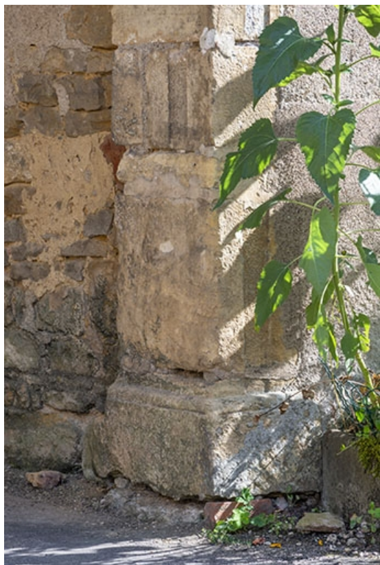
La base du piédroit du portail.
