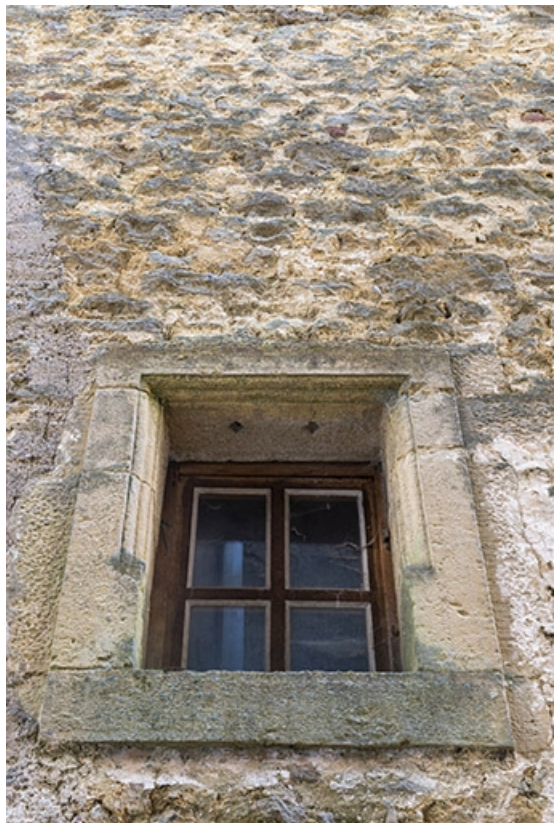
Une baie de l'étage, côté cour.
