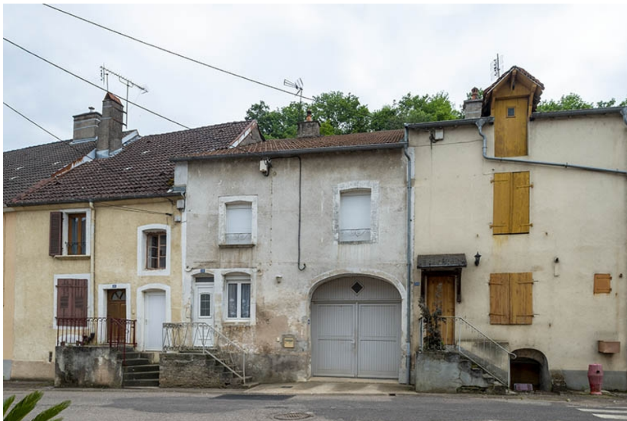
Les n° 36, 38 et 40 de la rue Thiers. 70, Jussey rue du Parlement
