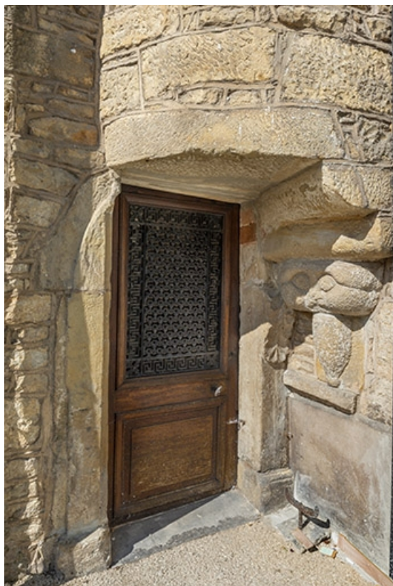
La porte de l'escalier.
