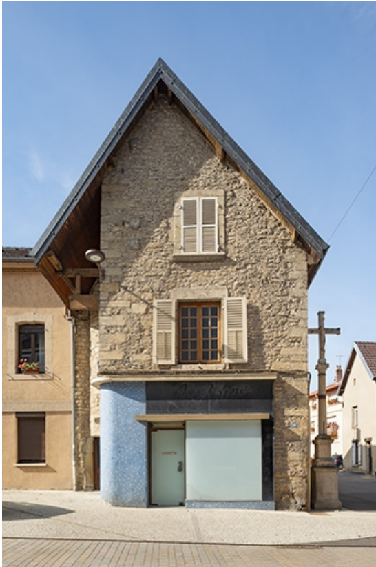
Le pignon depuis la rue Gambetta.
