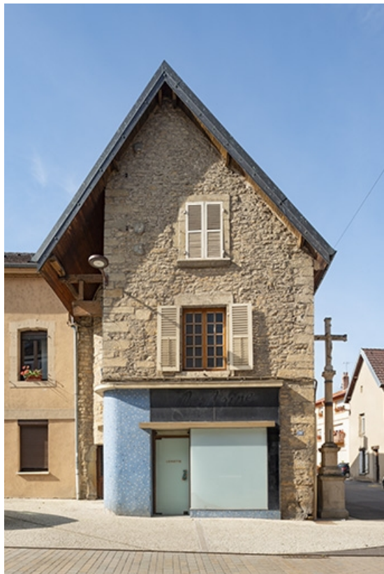
Le pignon depuis la rue Gambetta.
