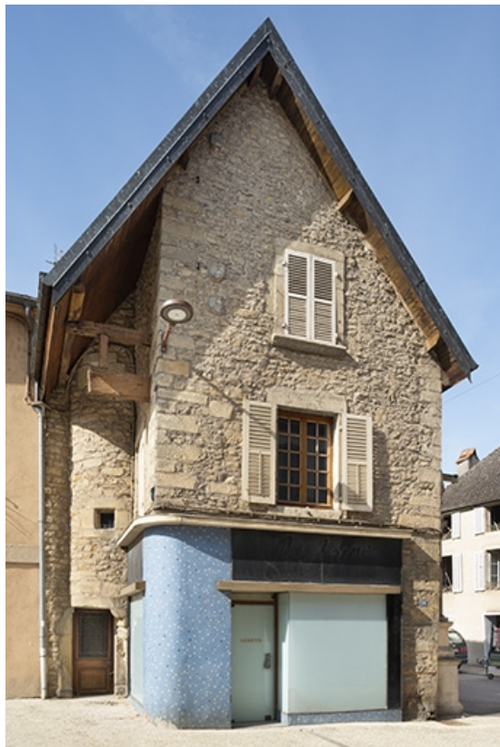
Le pignon et l'escalier, depuis la rue Gambetta.
