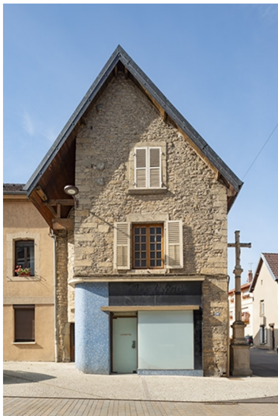
Le pignon depuis la rue Gambetta.
