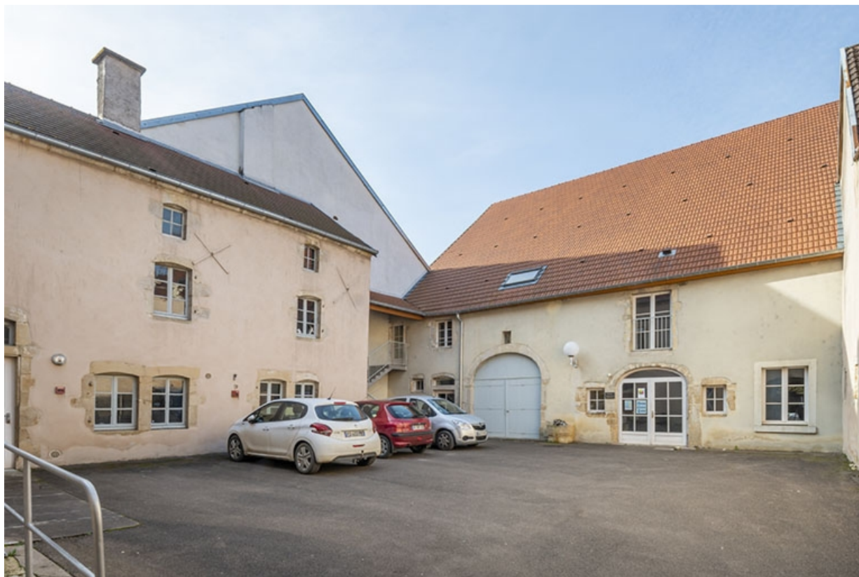
La cour, vue en direction du sud.
