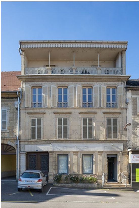
Façade de l'immeuble sur la rue.
