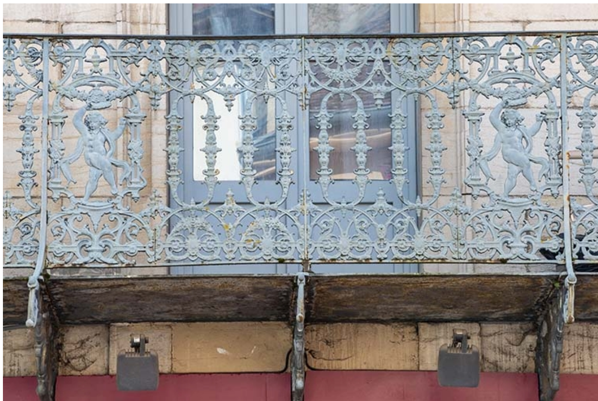
Détail du balcon du premier étage.
