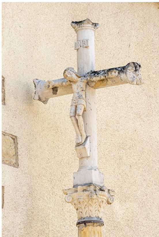
Détail de croix, trois quarts avant droit.
