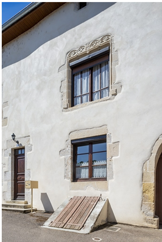
Détail de la façade, de l'entrée du cellier et des baies du n° 37. 70, Jussey rue Charles Rech
