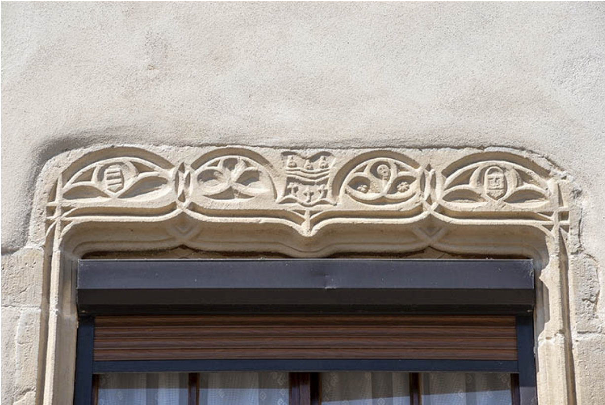
Détail du premier étage du n° 37 : linteau sculpté de la baie. 70, Jussey rue Charles Rech
