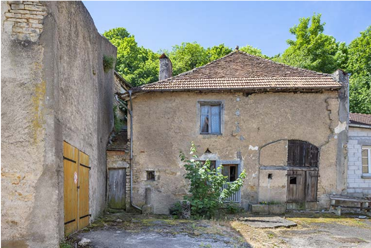
Façade antérieur de la ferme au n° 69. 70, Jussey rue Charles Rech
