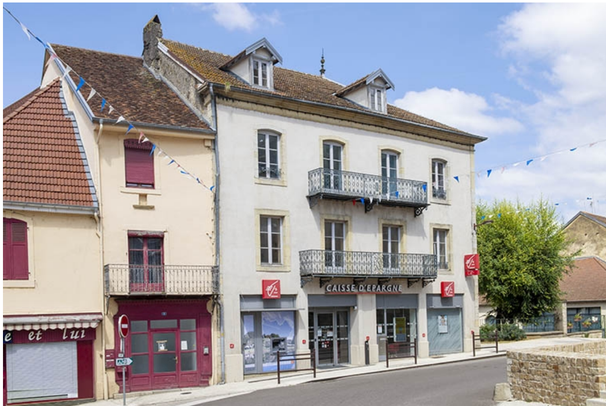
Trois quarts gauche des maisons à boutiques et immeuble aux n° 1, 3 et 5. 70, Jussey, 5-7 rue de l' hôtel de ville
