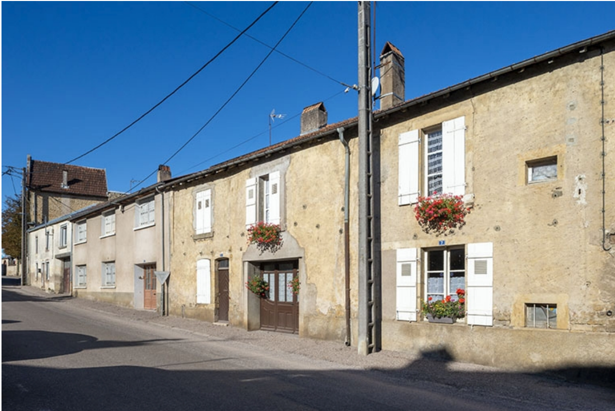
Trois quarts droit des façades des maisons, 7, 5 et suivants, vers le sud-ouest. 70, Jussey rue de la Pêcherie
