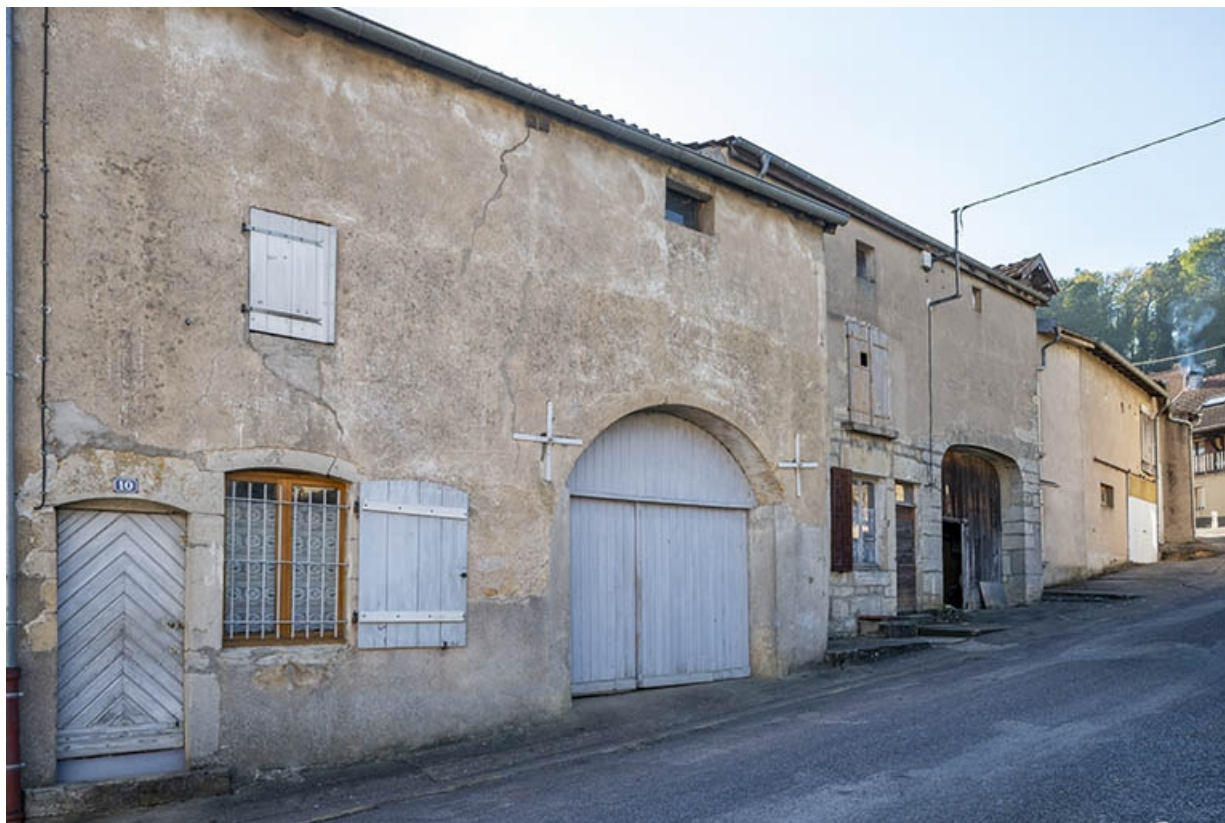
Trois quarts gauche des façades des maisons et fermes, 10, 8 et suivants, vers le sud. 70, Jussey rue de la Pêcherie
