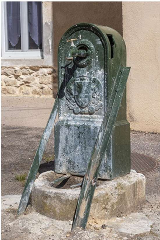
Rue Thiers, la borne fontaine au n° 37.
