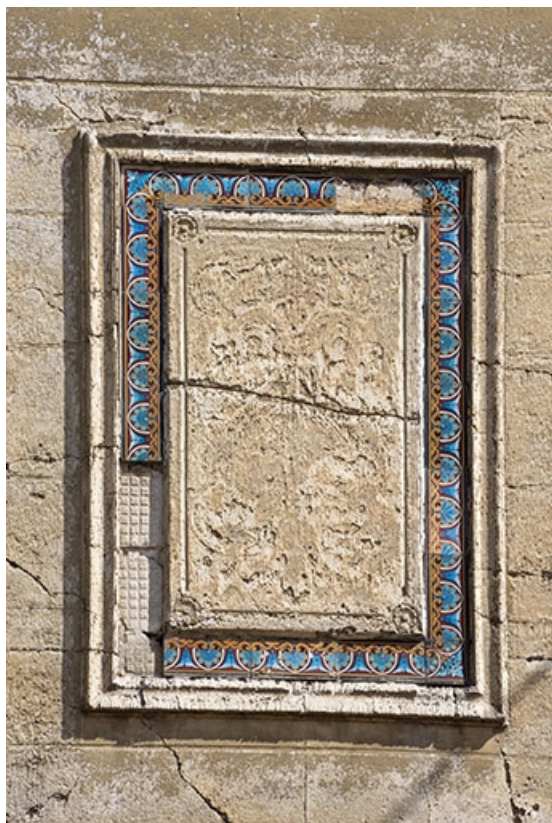
Détail de décor polychrome en céramique sur la façade.
