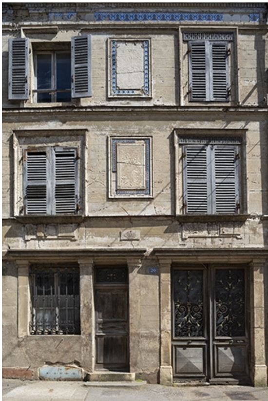
Le rez-de-chaussée et les deux étages carrés. 70, Jussey rue Adolphe-Thiers
