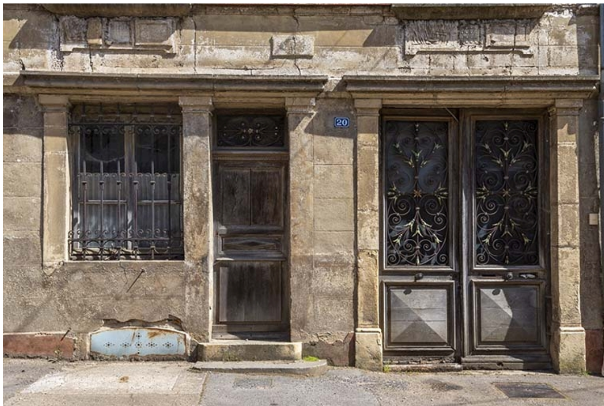
Pilastres, ferronnerie, menuiserie, bas-relief sur la façade.
