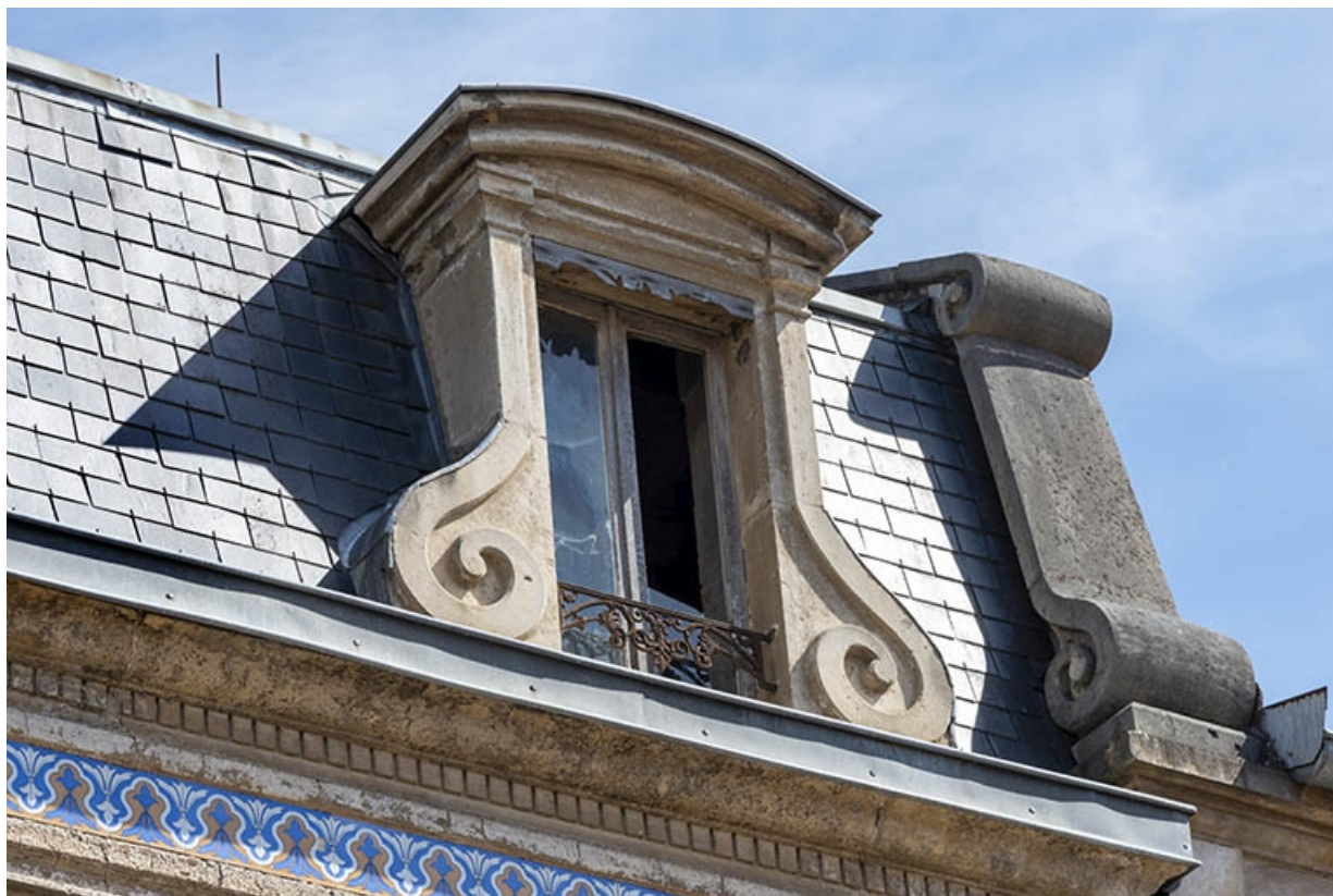
Détail de la lucarne sur le brisis, à droite.
