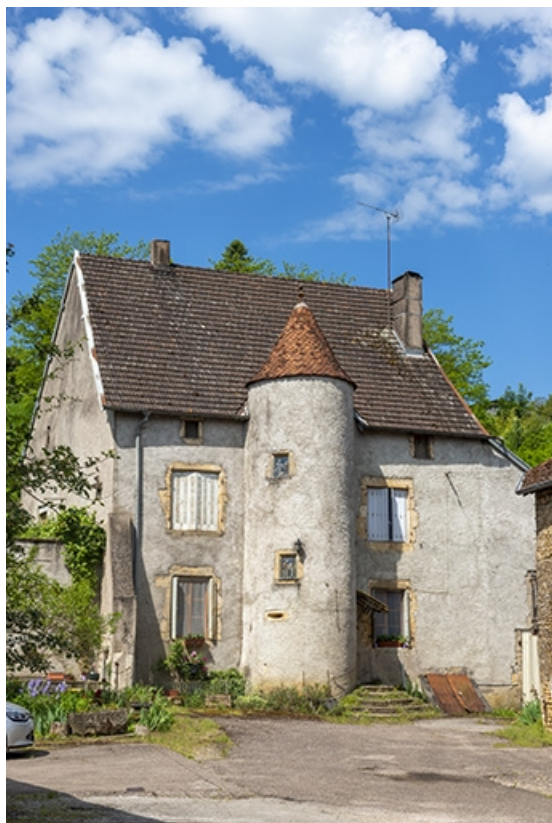
La façade antérieure depuis la rue.
