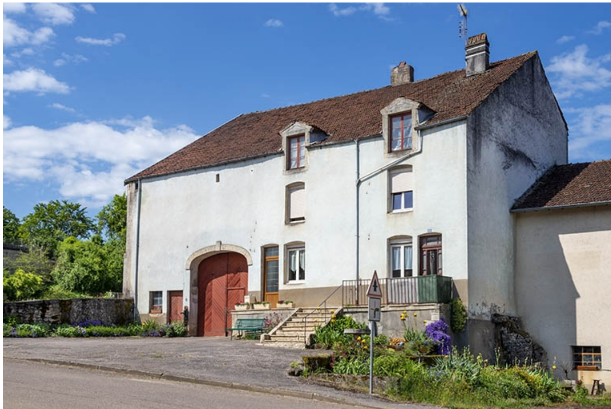
La façade de trois quarts droite depuis la rue. 70, Jussey, 66 rue Charles-Bontemps
