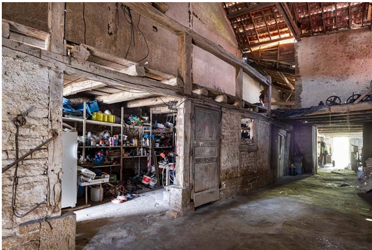
L'intérieur des parties agricoles, face à l'ouest.
