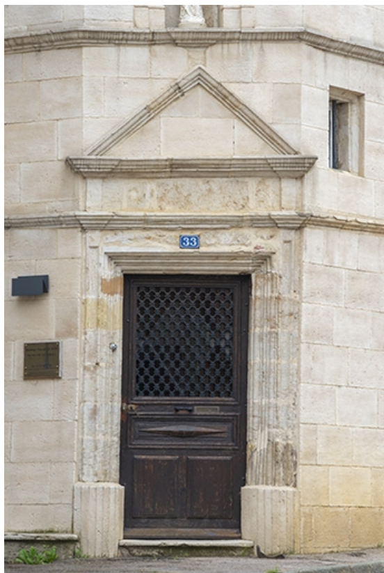
Vue rapprochée de la porte d'entrée.
