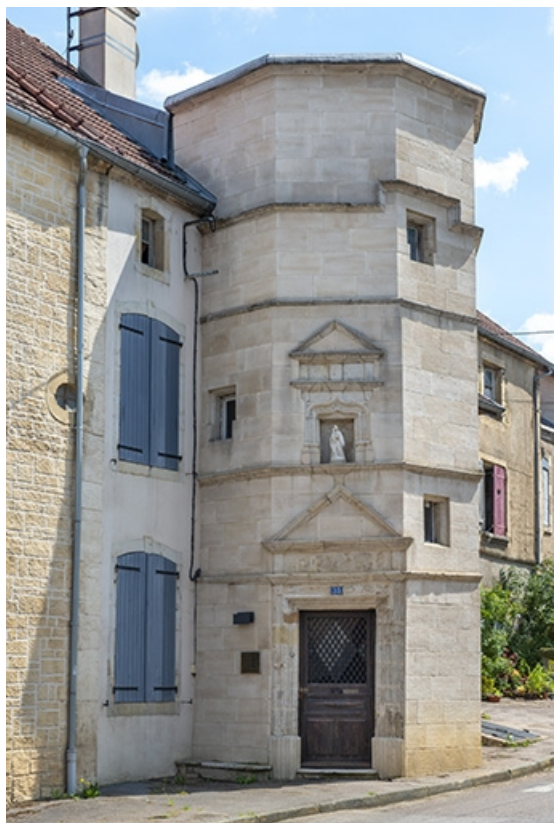
Vue rapprochée de la tour d'escalier, face à sa porte.
