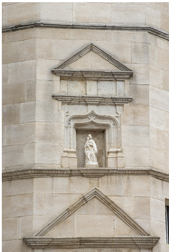
Vue rapprochée des deux frontons et de la sculpture de la tour d'escalier.
