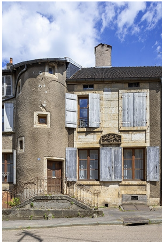
La façade antérieure, vue rapprochée.
