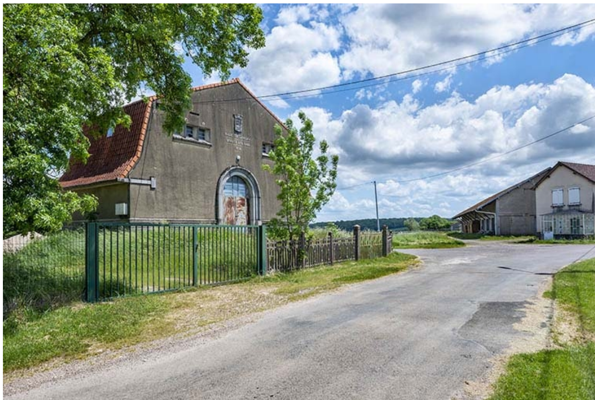
Le bâtiment des eaux de la rue du Bac, de trois quarts gauche, dans l'environnement.
