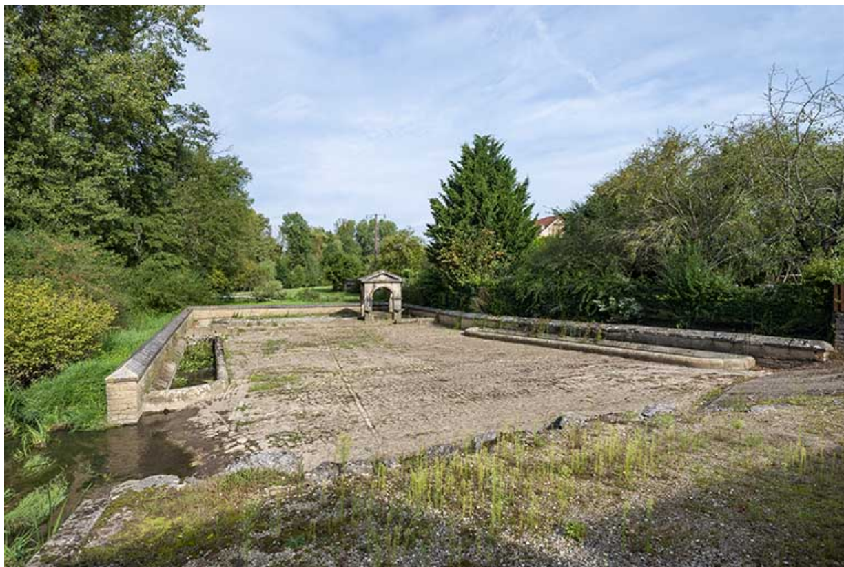
Fontaine, lavoir et abreuvoirs construits en 1834. Vue d'ensemble. 70, Soing-Cubry-Charentenay
