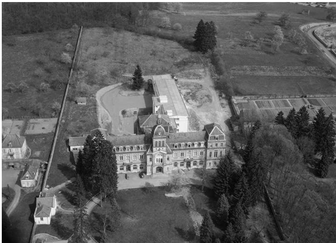
Vue aérienne montrant l'agrandissement de l'hôpital vers l'est.
