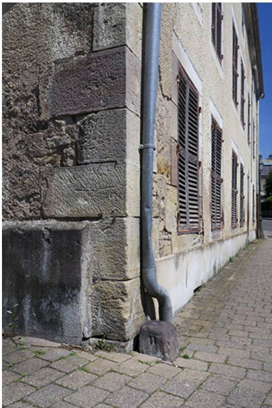
Vue de la borne à l'angle de la rue Jean Jaurès et de la rue de la Saline. 70, Luxeuil-les-Bains rue Jean Jaurès
