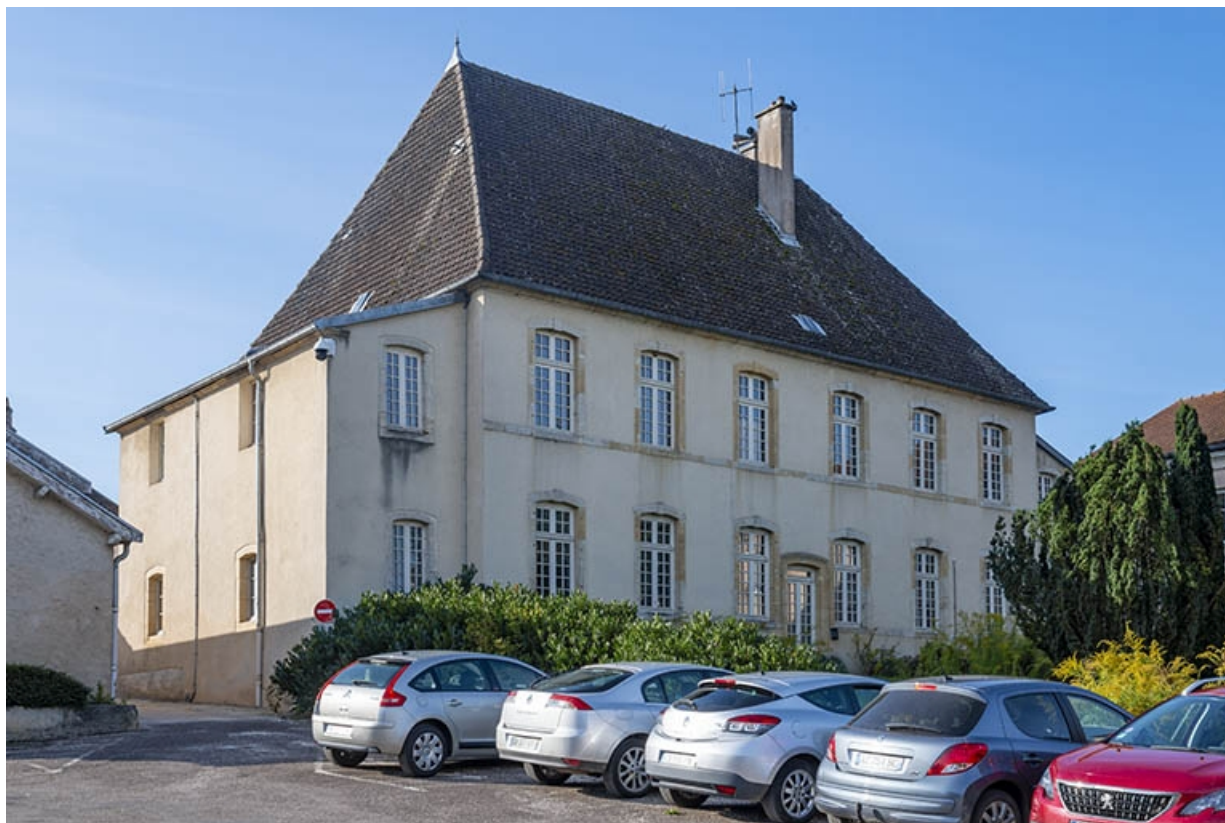
L'arrière, façade nord.
