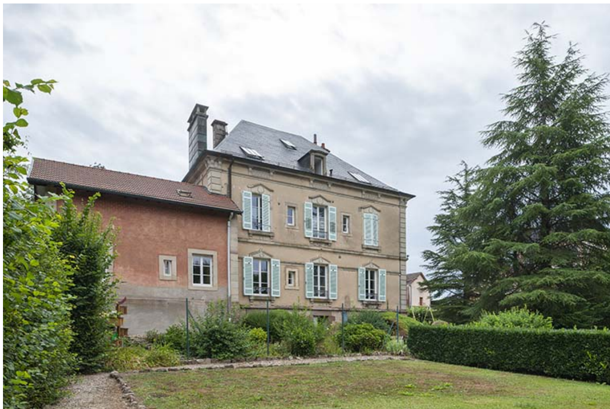
Façade ouest, vue depuis le jardin, avec le garage à gauche.
