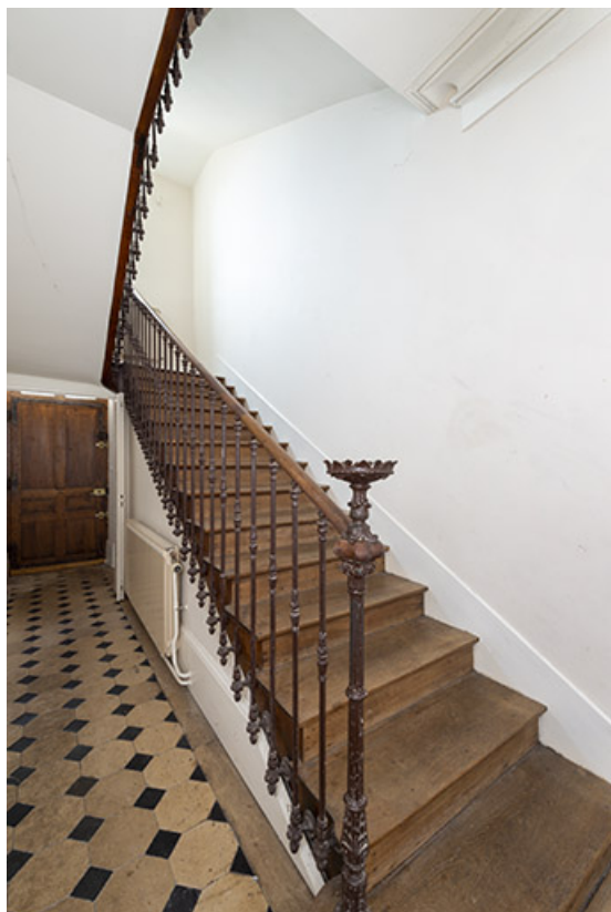
Escalier rampe-sur-rampe avec repos formant retour complet à gauche, vue depuis le palier du rez-de-chaussée. 70, Luxeuil-les-Bains, 3 rue de Grammont
