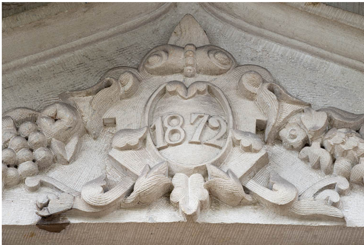
Décor sculpté au-dessus de la porte d'entrée : date (1872) dans un cartouche, cuirs découpés et guirlandes végétales. 70, Luxeuil-les-Bains, 3 rue de Grammont
