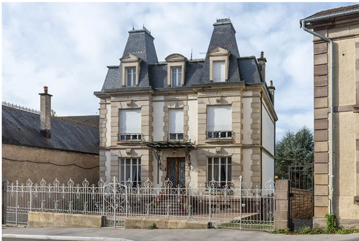
Façade principale, vue de trois quarts depuis le nord-est.
