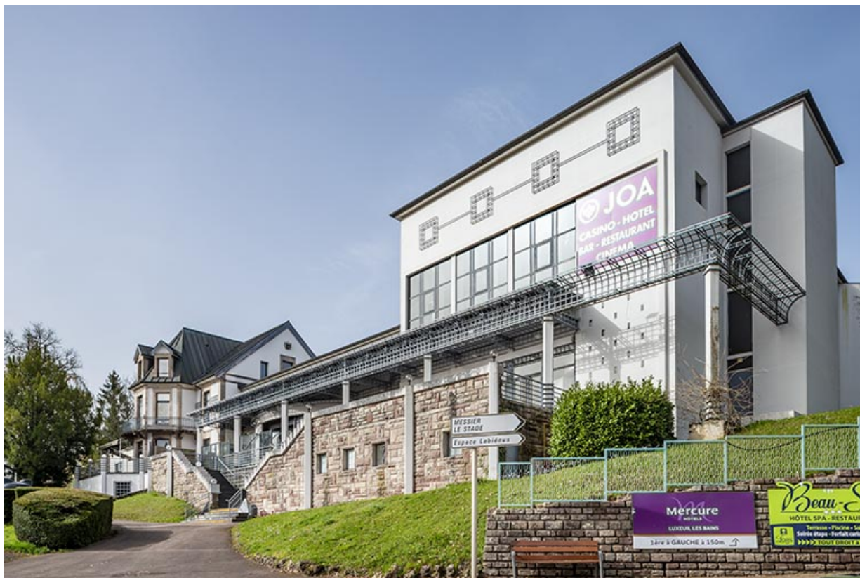
Salle des fêtes, vue depuis le nord-ouest.
