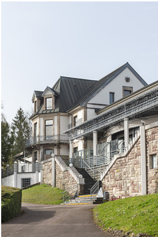
Maison, vue depuis le nord.
