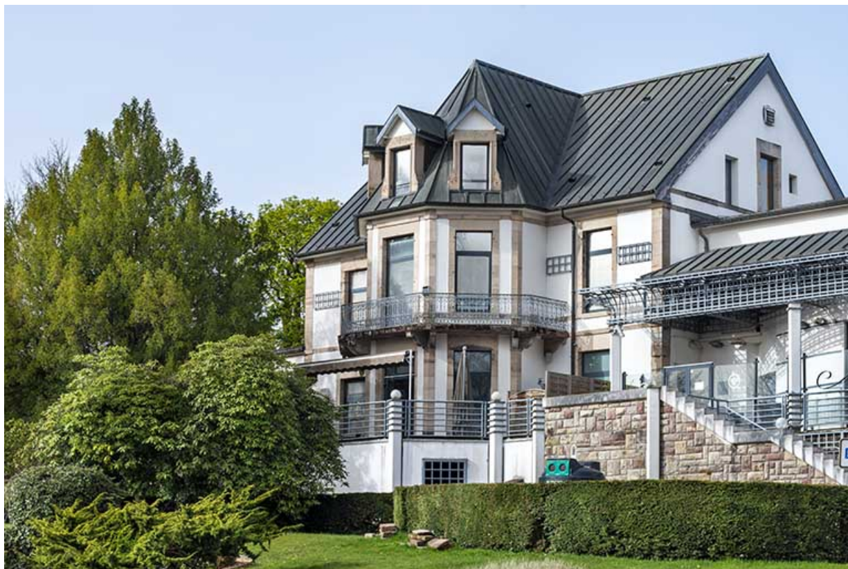
Maison, vue depuis le nord.
