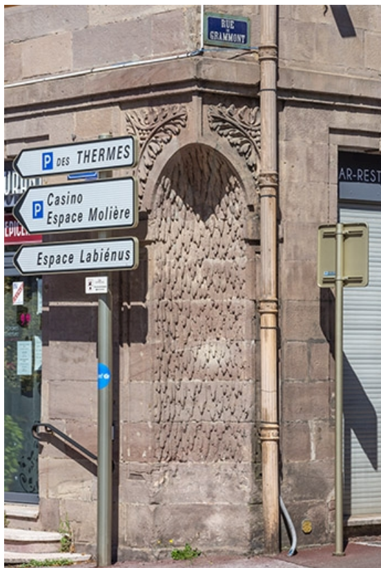
Maison Desgranges, niche dans l'angle. 70, Luxeuil-les-Bains, 1 rue de Grammont
