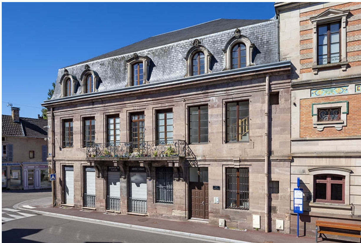
Maison Desgranges, façade est.
