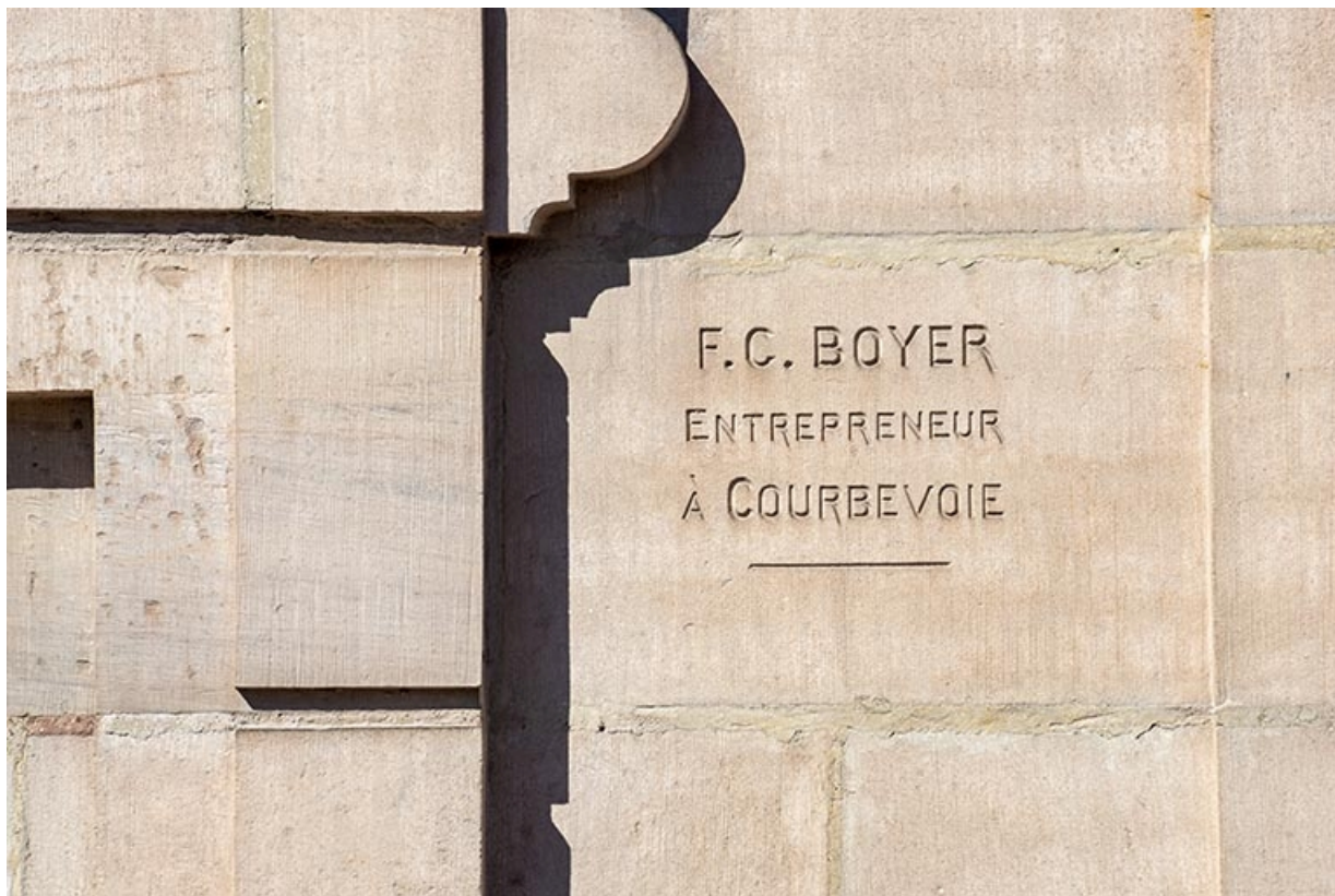
Façade sur la rue de Grammont, partie centrale, inscription : "F.C. BOYER / ENTREPRENEUR / À COURBEVOIE". 70, Luxeuil-les-Bains, 1 rue de Grammont
