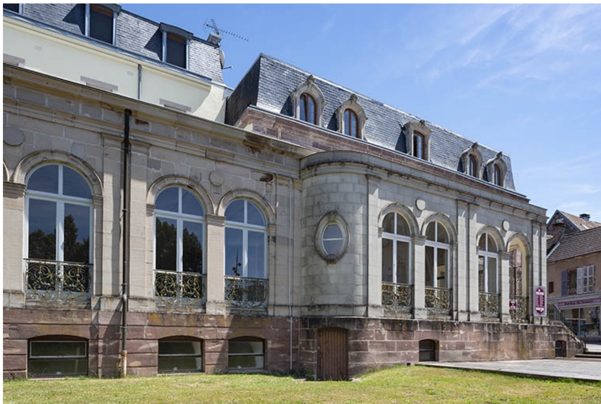
Galerie en façade ouest, vue depuis le nord-ouest (vue rapprochée). 70, Luxeuil-les-Bains, 1 rue de Grammont
