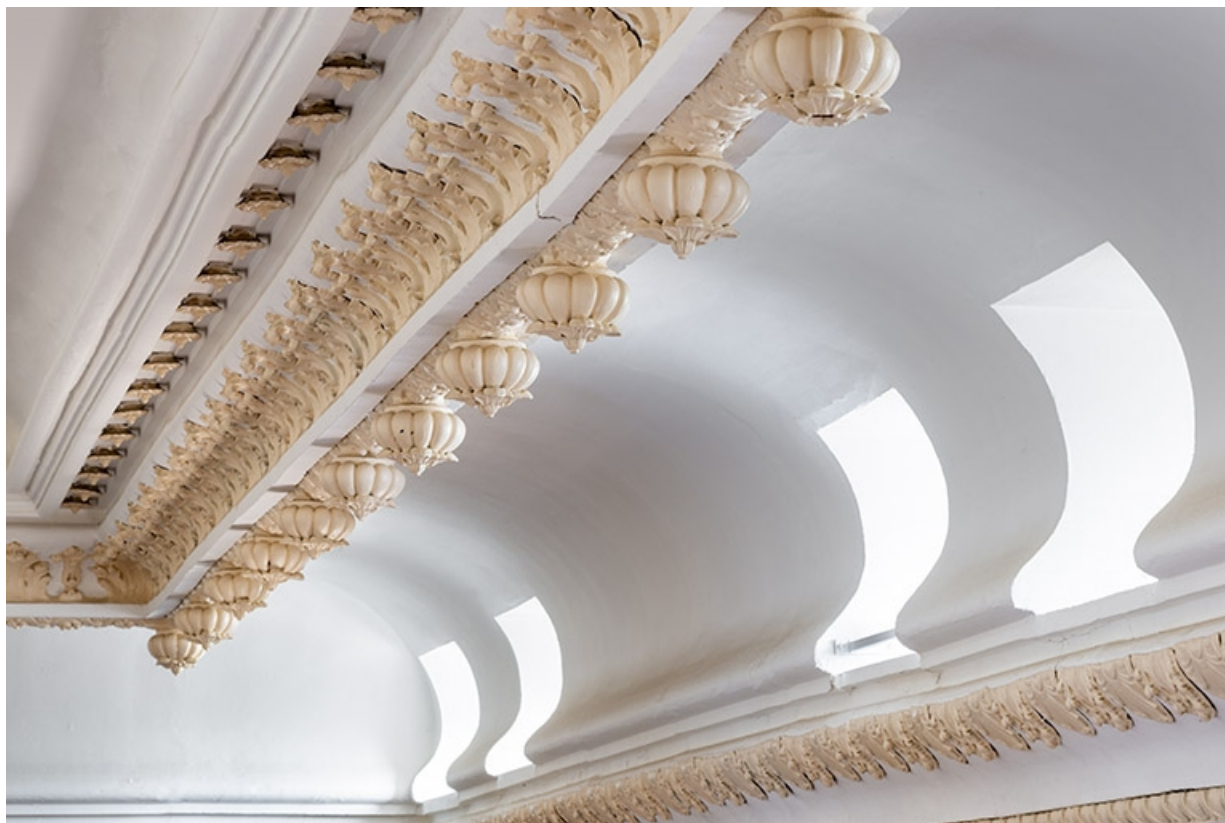
Salle : voussure (vue de trois quarts). 70, Luxeuil-les-Bains, 1 rue de Grammont
