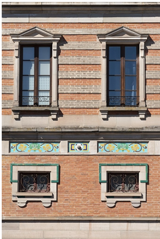
Façade sur la rue de Grammont, baies du deuxième et du troisième niveau. 70, Luxeuil-les-Bains, 1 rue de Grammont
