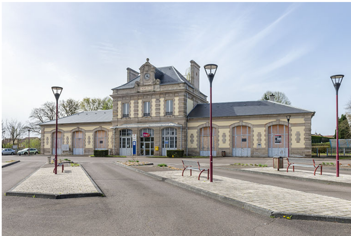
Vue d'ensemble depuis la place de la gare.
