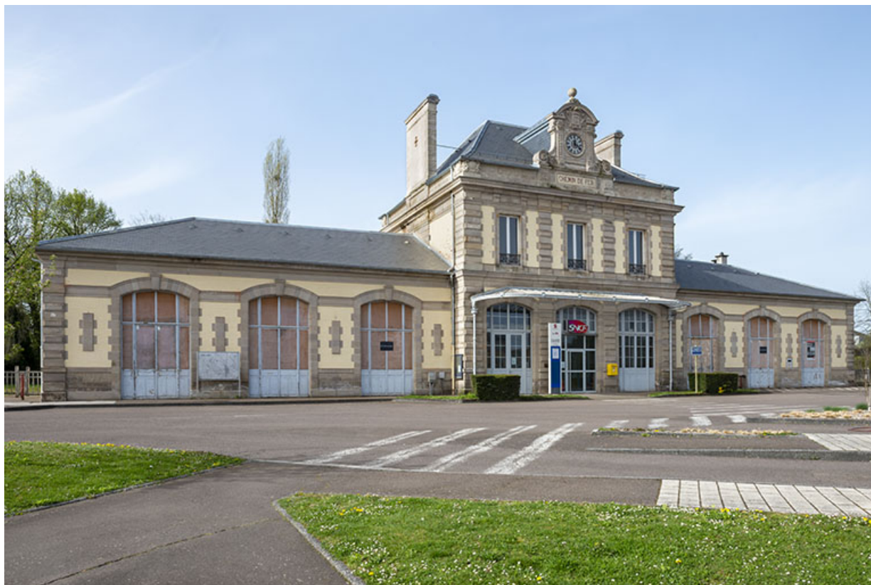
Façade, vue de trois quarts.
