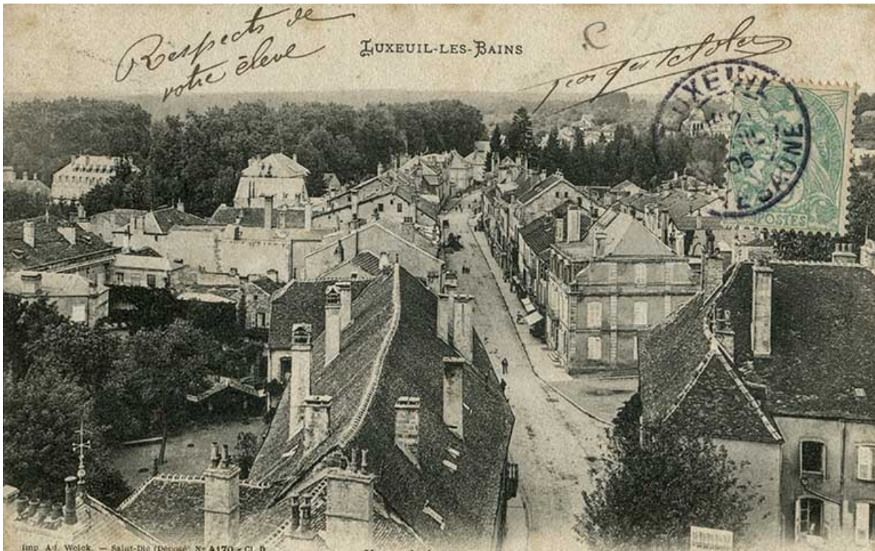
Rue Carnot, vue en direction du nord.
