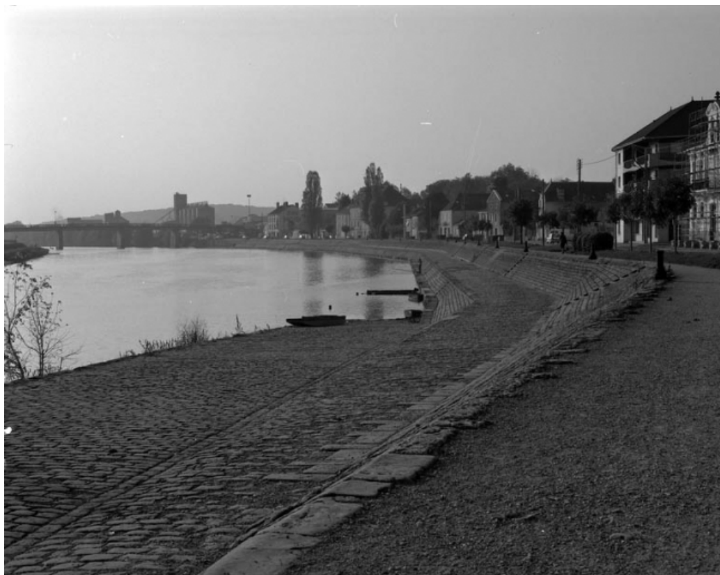
Vue d'ensemble du quai Villeneuve avec les silos en arrière-plan. 70, Gray
