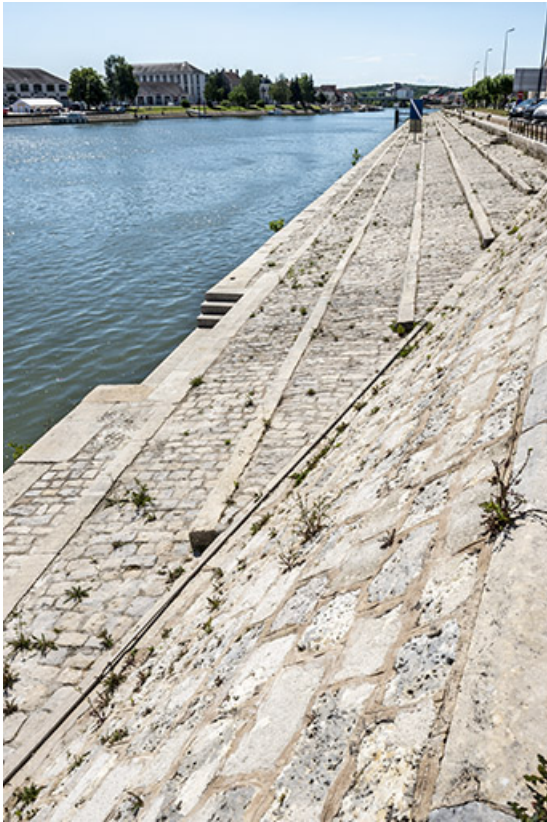
Détail de la maçonnerie du quai.
