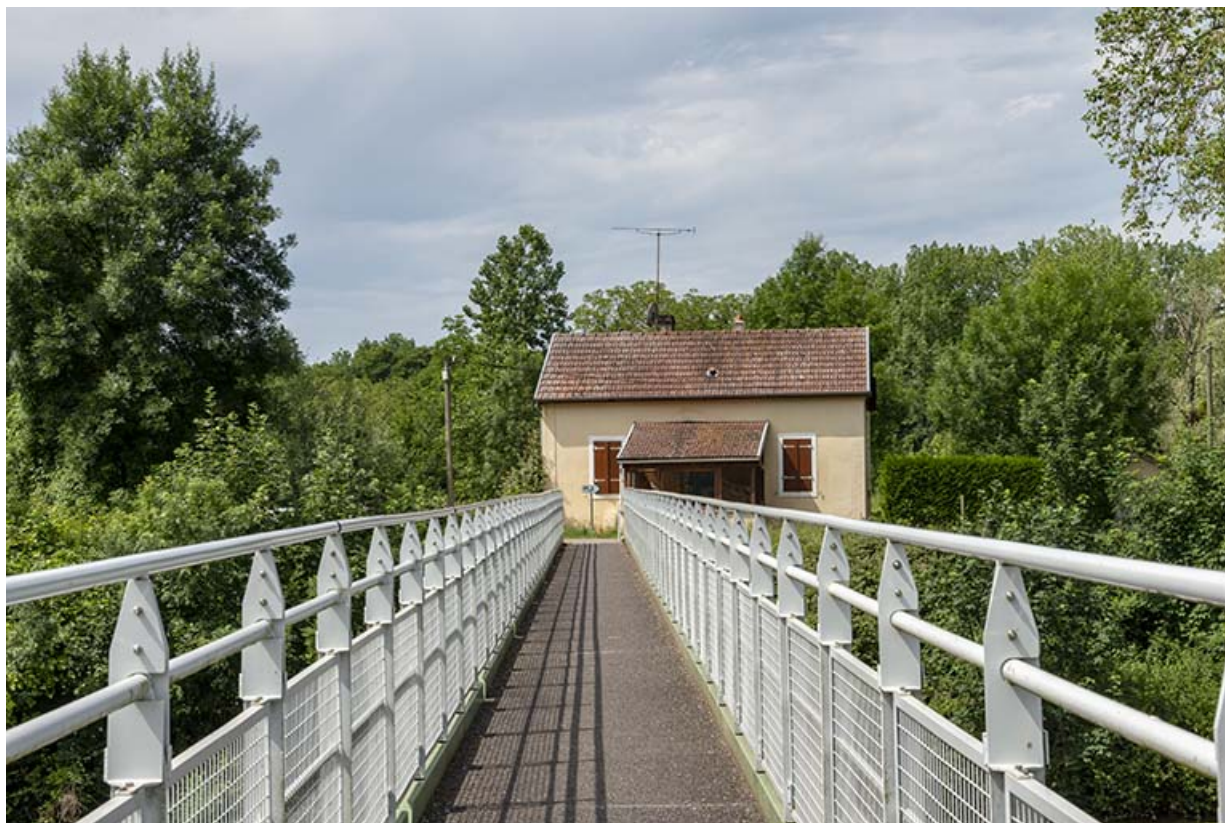
Vue de détail de la passerelle.
