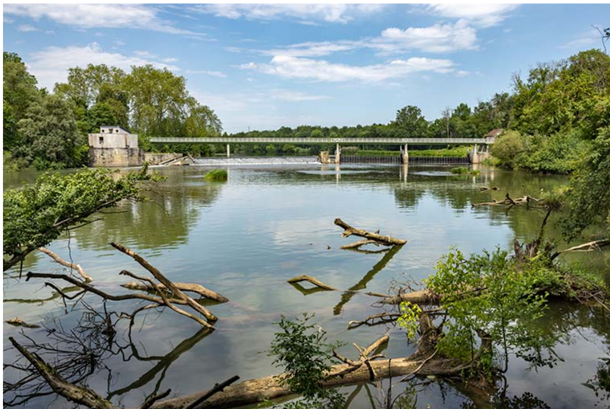
Vue générale depuis l'aval.
