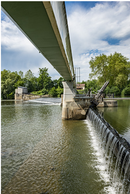
Barrage mobile d'Apremont.
