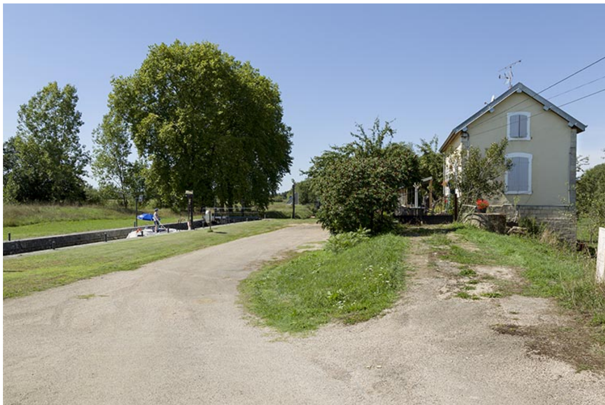
Vue depuis l'amont.
