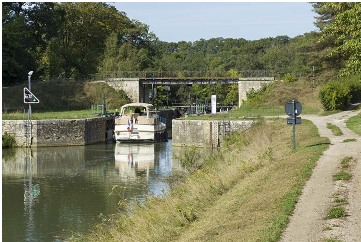
Bateau en amont de l'écluse à sas.
