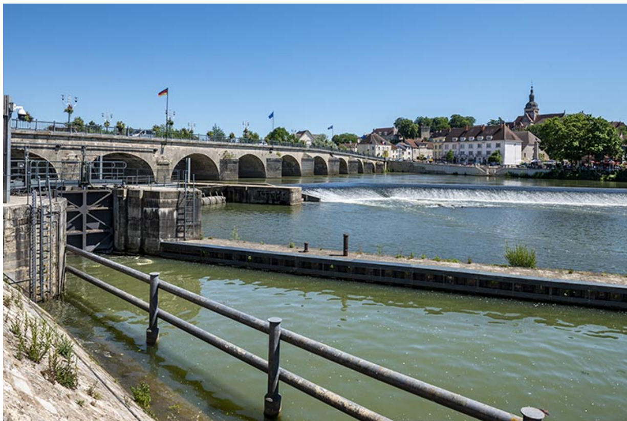
Vue générale du début du bief d'Apremont. 70, Apremont
