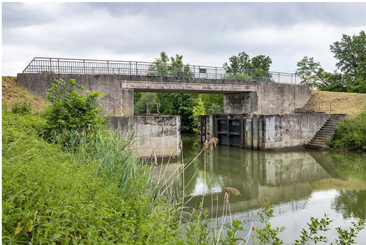
Vue aval de la porte de garde.
