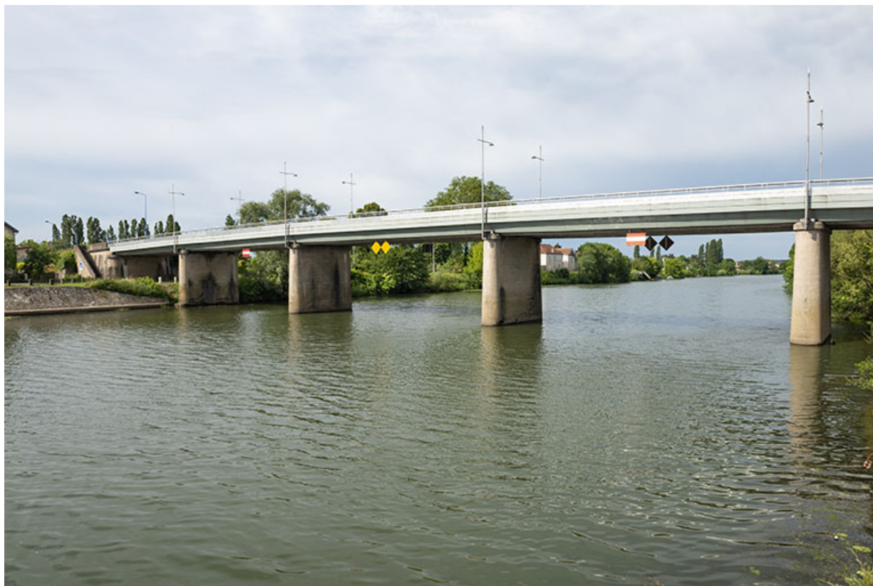
Le pont reconstruit après guerre.
