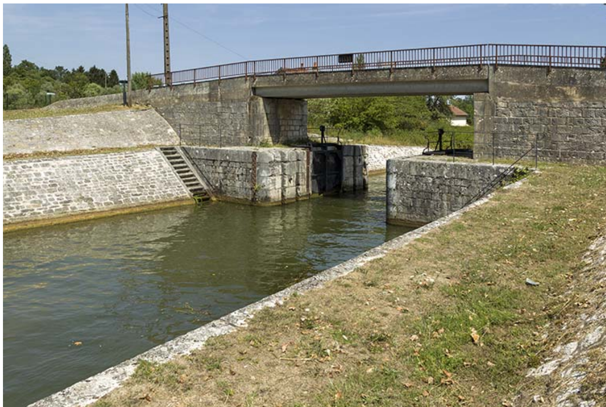
La porte de garde à l'entrée du canal. 70, Rigny
