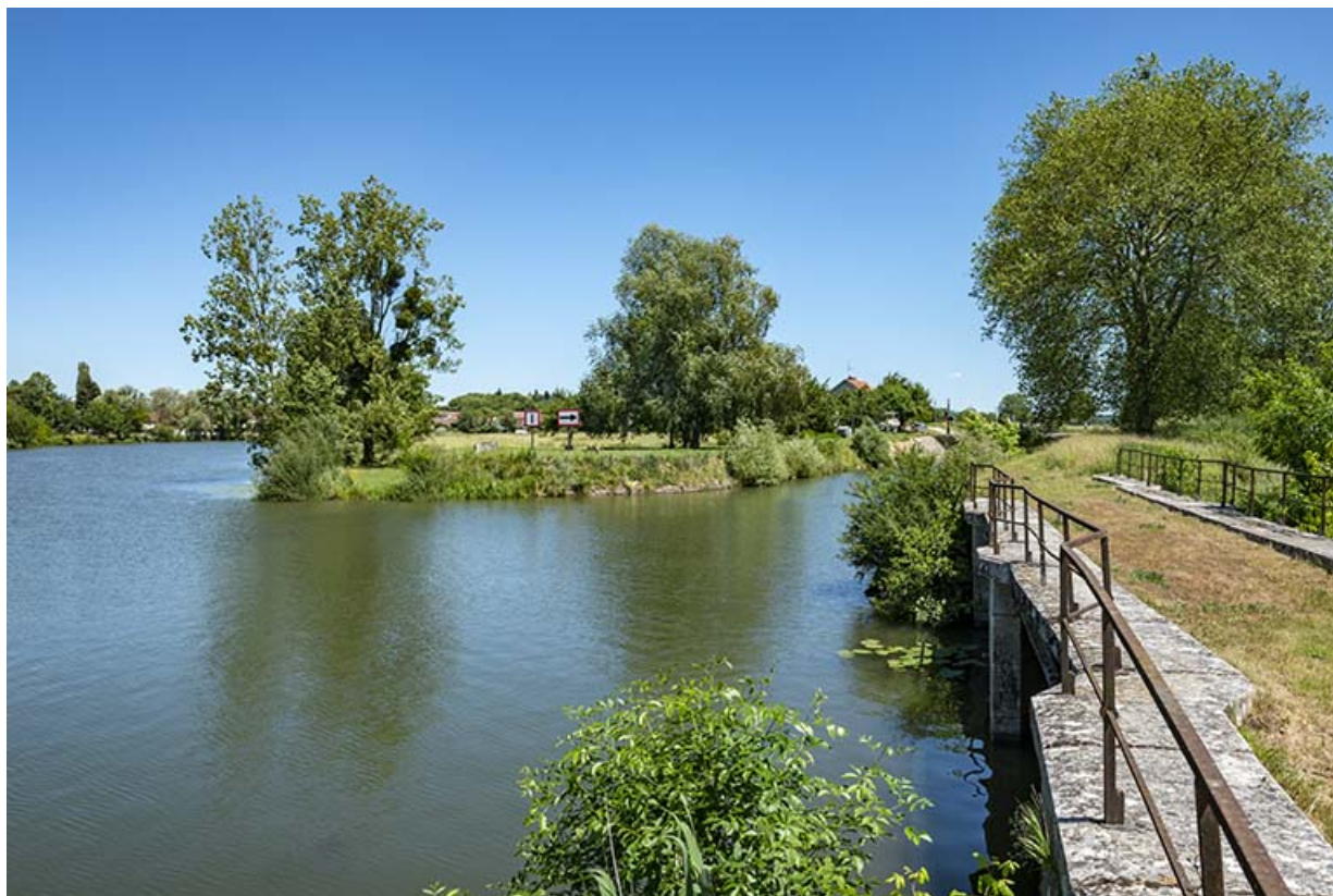
Sortie aval de la dérivation.
