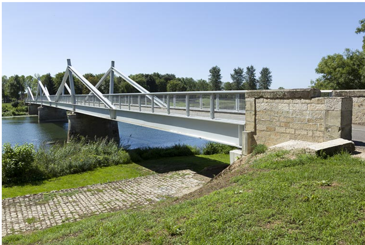
Le pont de Rigny et le chemin de halage en contrebas. 70, Rigny
