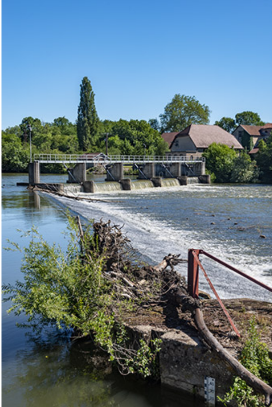
Culée du barrage.
