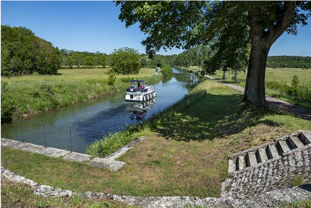
Vue depuis la porte de garde.
