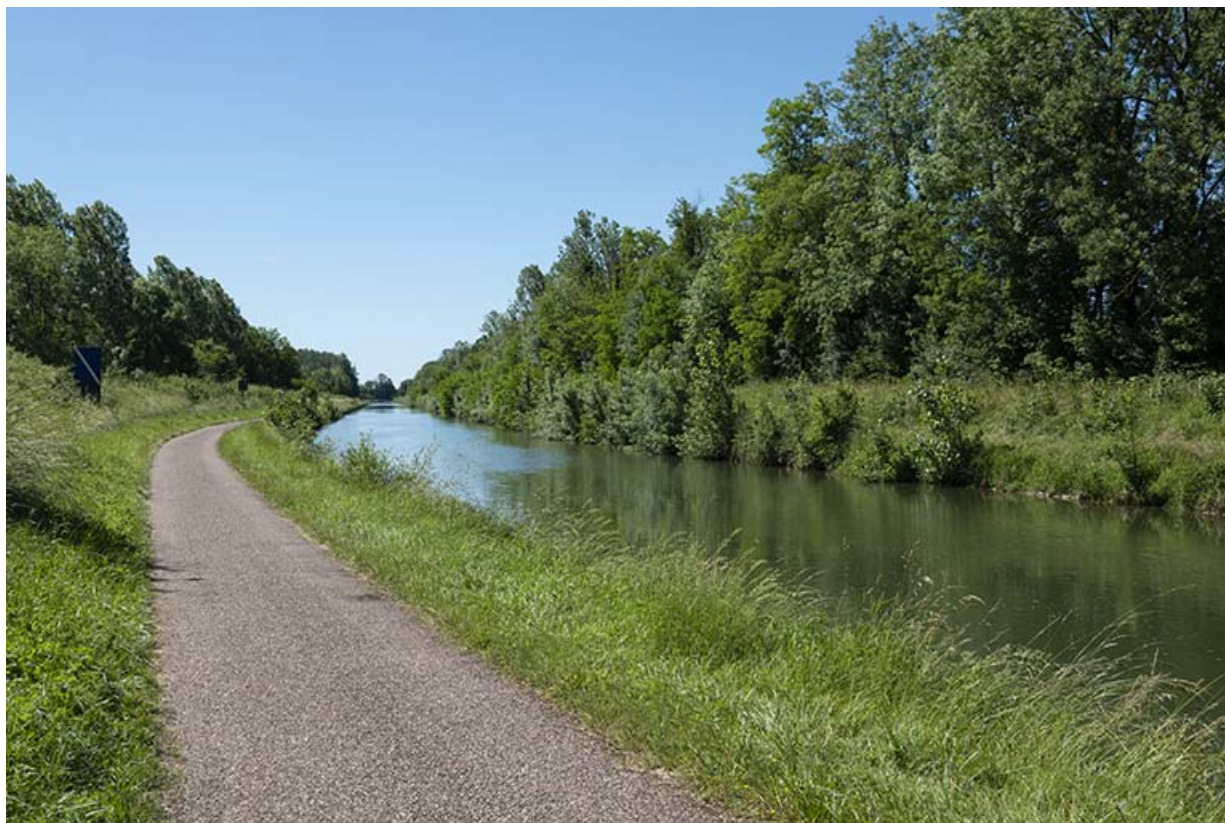
La dérivation et le chemin de halage transformé en piste cyclable. 70, Vereux
