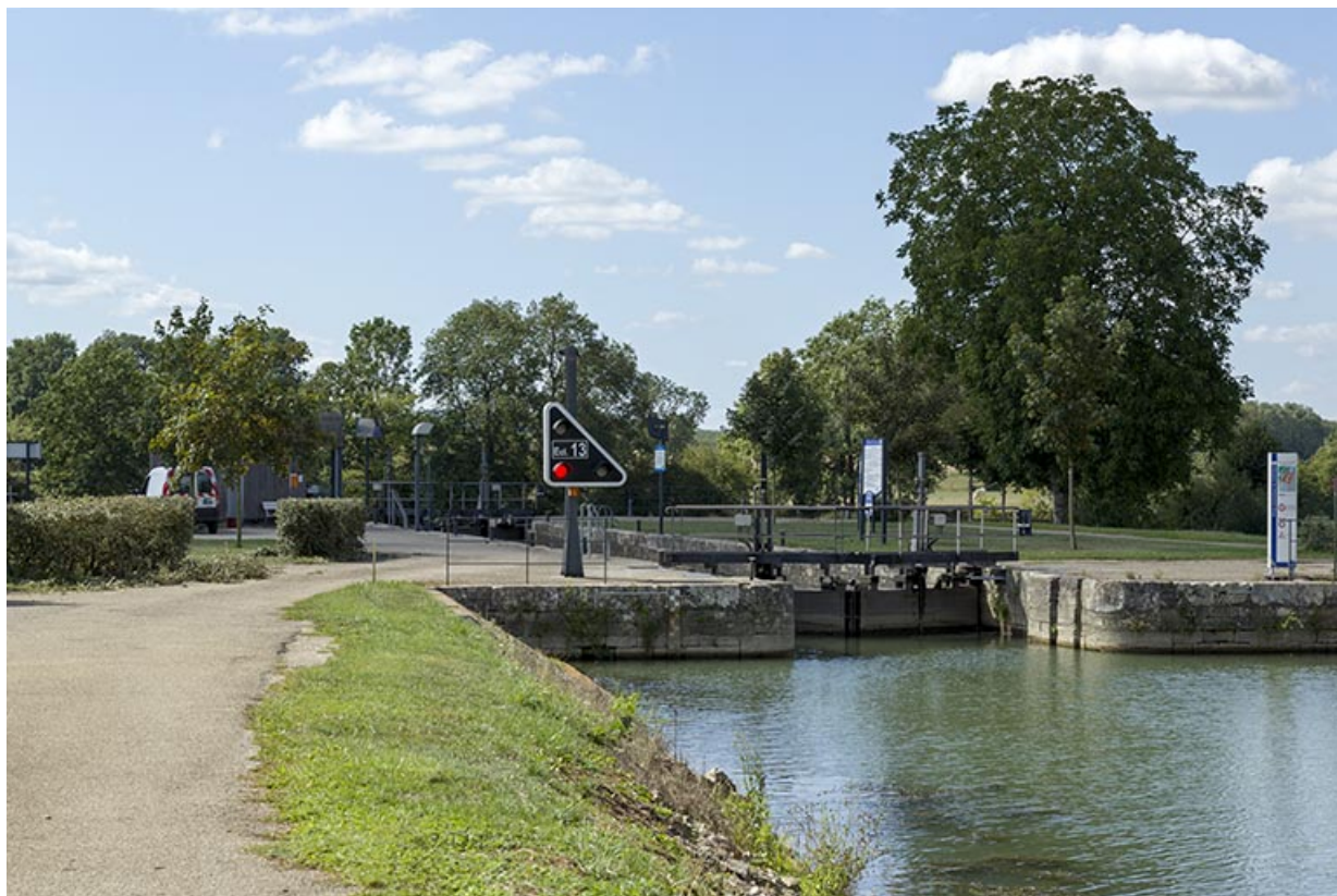
Entrée amont de l'écluse.
