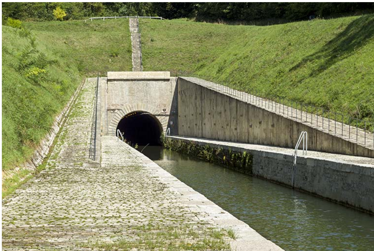
Entrée aval depuis le chemin de halage. 70, Savoyeux
