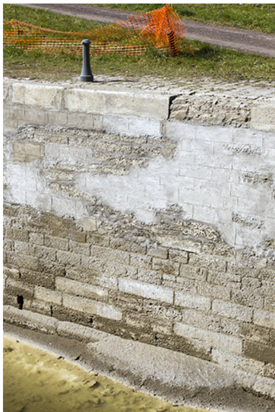
Détail de la maçonnerie lors des travaux de restauraton en 2015. 70, Savoyeux
