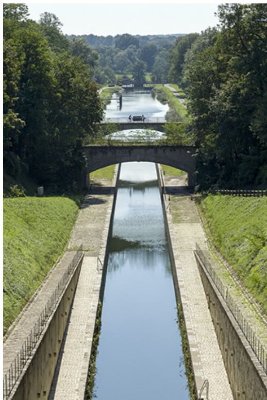
Vue aval, en direction de l'écluse.
