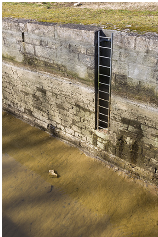
Mur latéral du canal.
