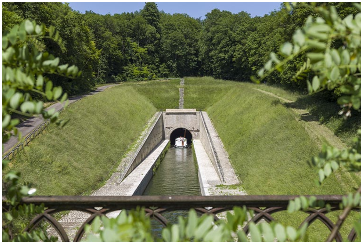
Entrée aval du tunnel, vue prise depuis le pont. 70, Savoyeux
