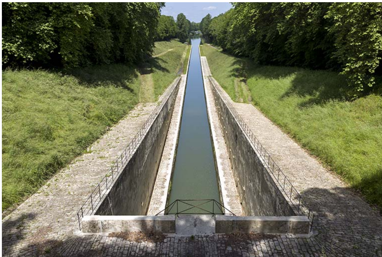
Le canal de navigation, vue amont.
