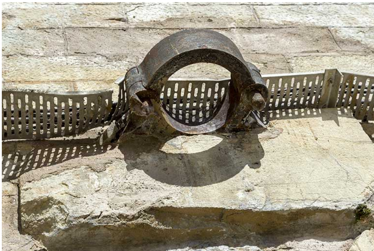
Gond d'une des anciennes portes du tunnel (entrée aval).
