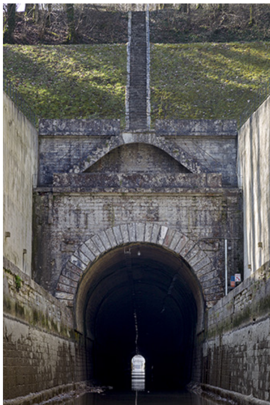
Entrée amont du souterrain.
