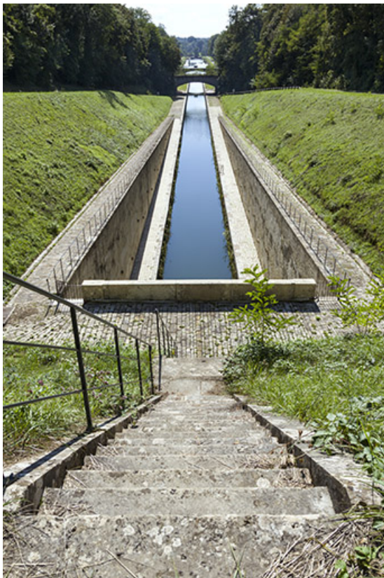
Le canal de navigation, partie aval.
