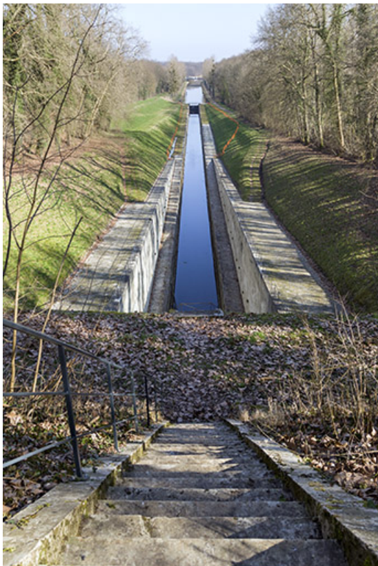
L'escalier et la terrasse au-dessus de l'entrée amont de l'ouvrage. 70, Savoyeux
