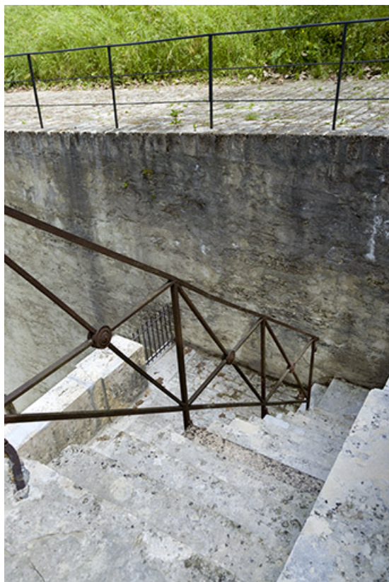
L'escalier et le garde-corps.
