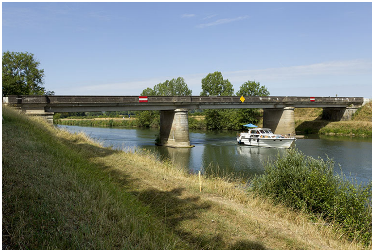
Le pont de Ray, point de départ du bief de Savoyeux. 70, Savoyeux
