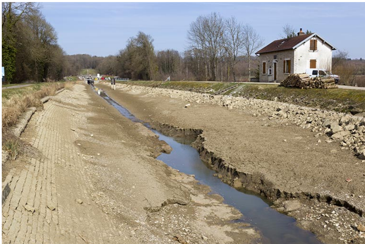
Travaux de curage du canal en 2015, partie aval de la dérivation de Savoyeux. 70, Savoyeux
