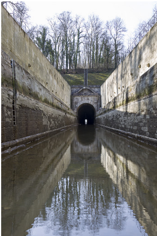
Le souterrain depuis la cuvette du canal.
