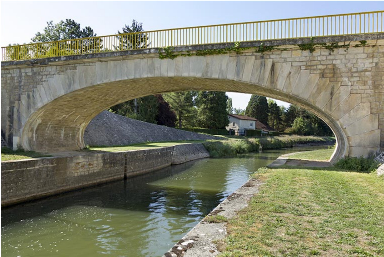
Le pont et son arc en forme d'ellipse. 70, Vanne
