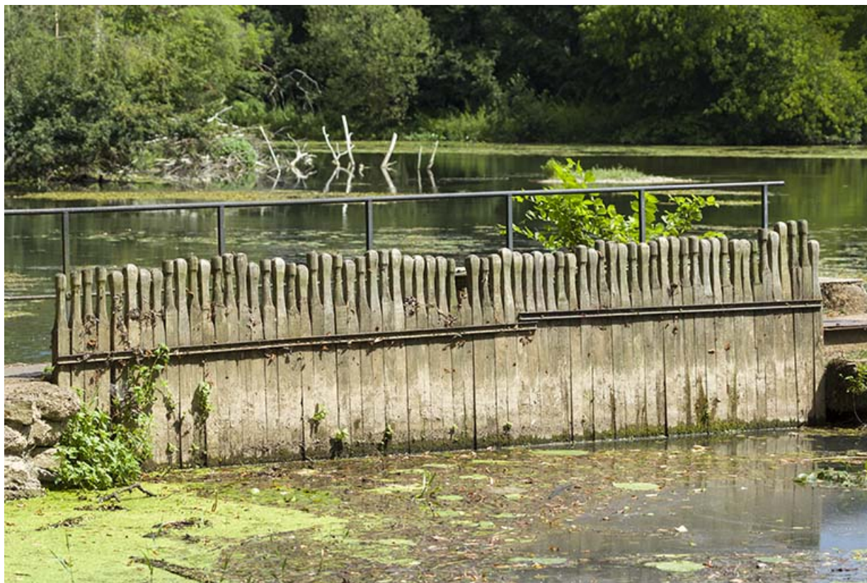
Aiguilles fermant l'ancien pertuis de navigation.
