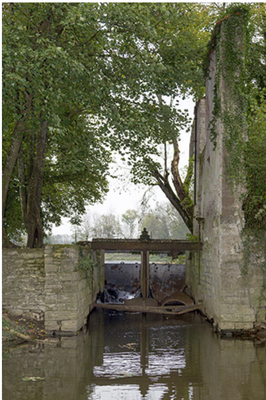
L'ancien canal de dérivation du moulin.
