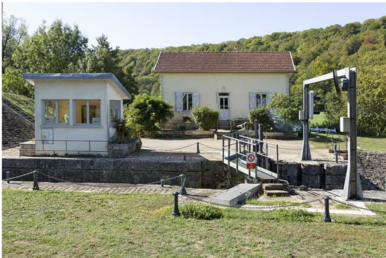
L'écluse, le poste de commande et la maison de l'éclusier. 70, Vanne
