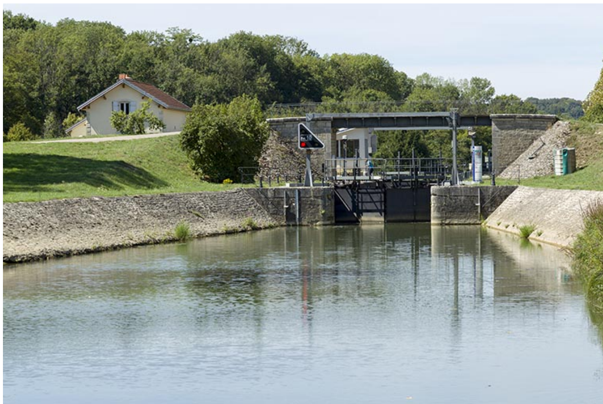
Entrée amont de l'écluse à sas.
