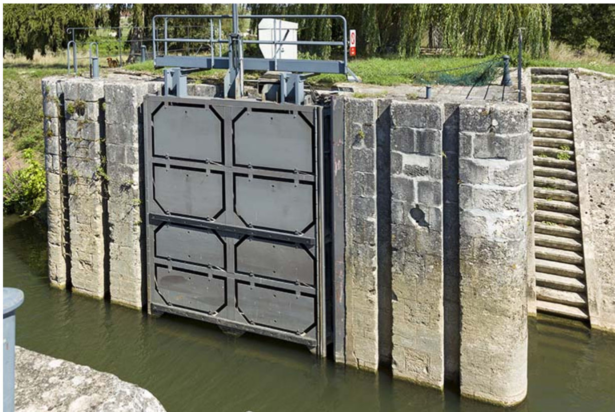
Vue d'un vantaill.
