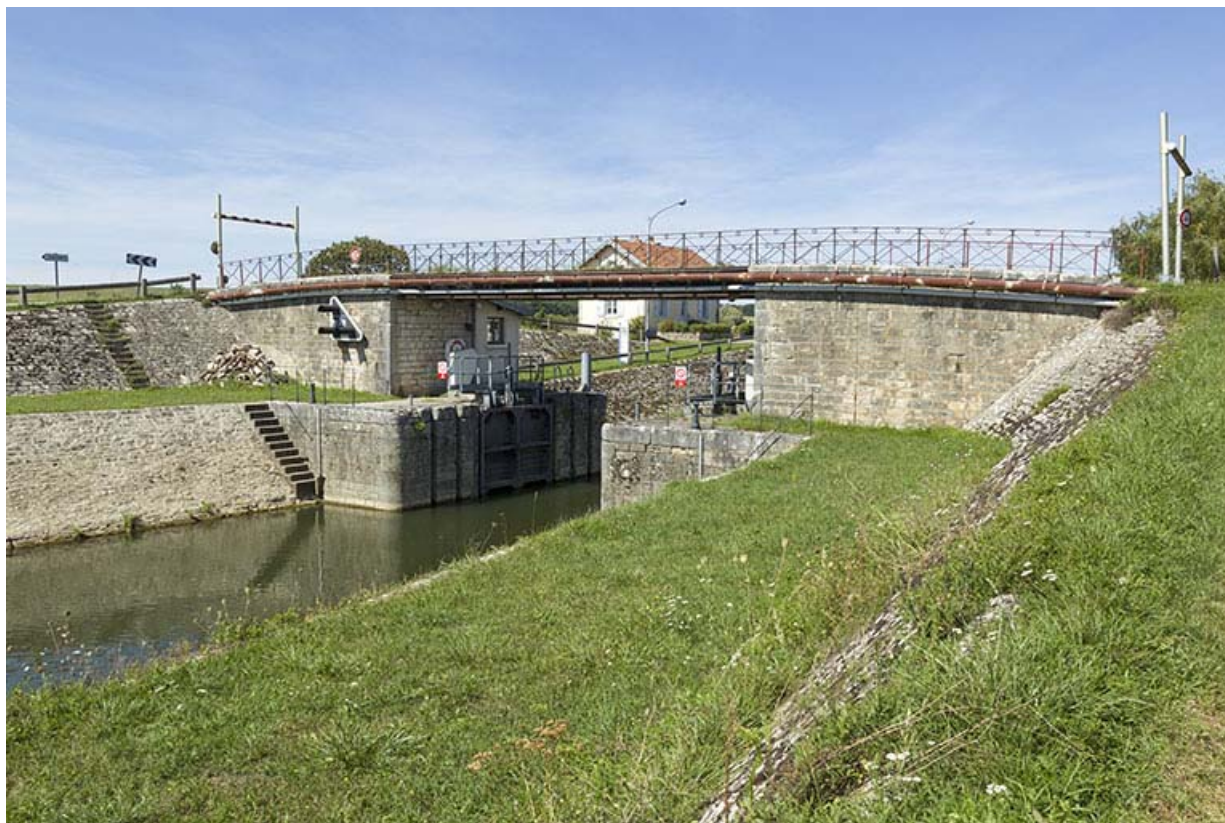
Bief aval de l'écluse.
