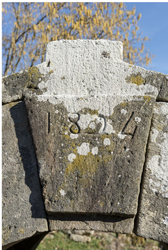
Date à la clé de de l'édicule sur la source juxtant le lavoir. 70, Cendrecourt
