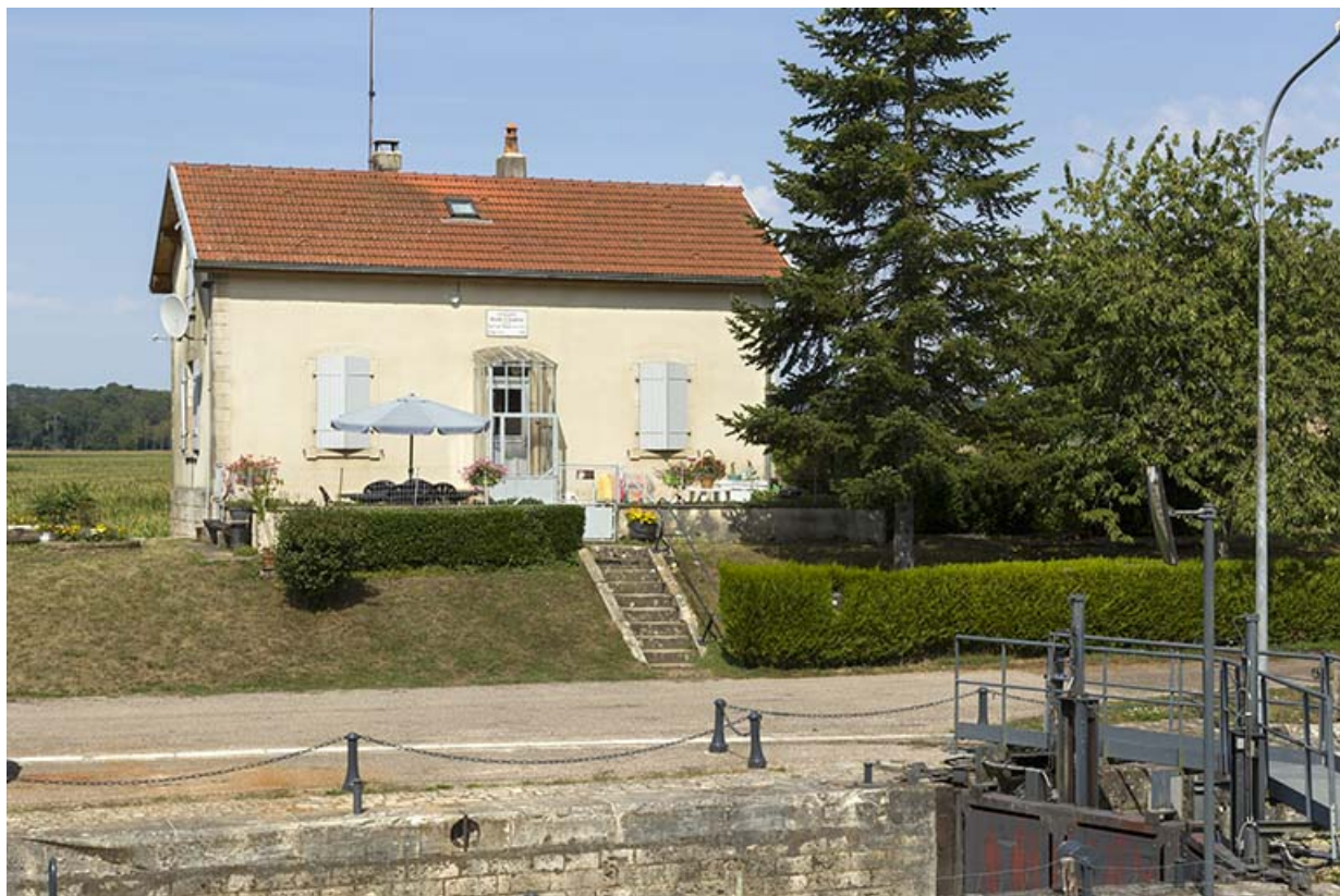
La maison d'éclusier. 70, Rupt-sur-Saône
