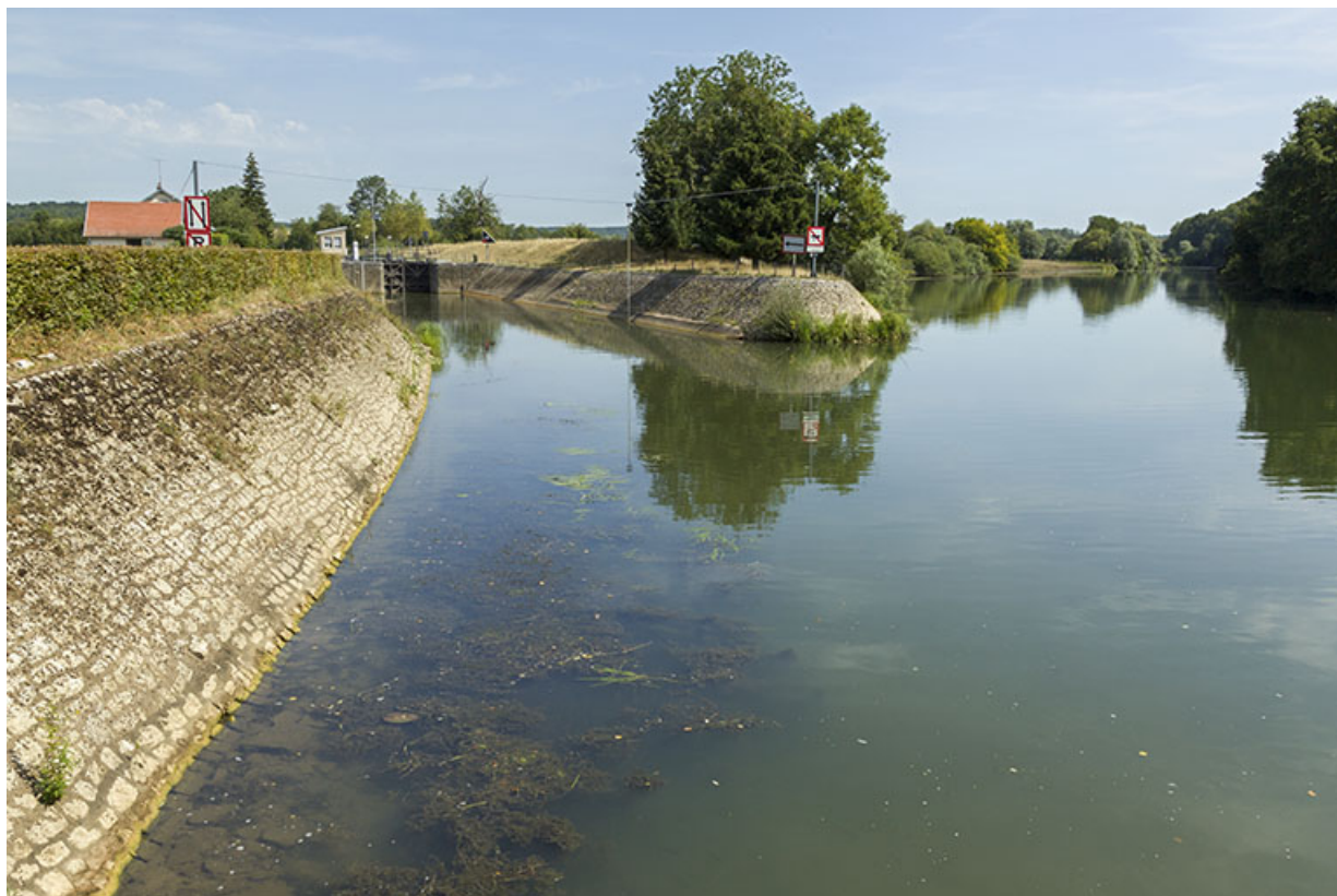
Fin de la dérivation de Chantes en aval de l'écluse.
