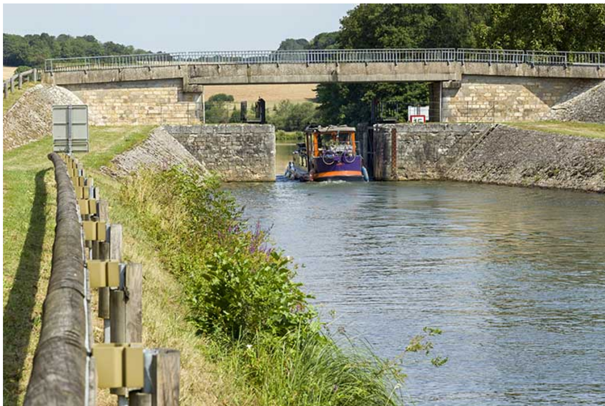
Vue aval de la porte de garde. 70, Chantes
