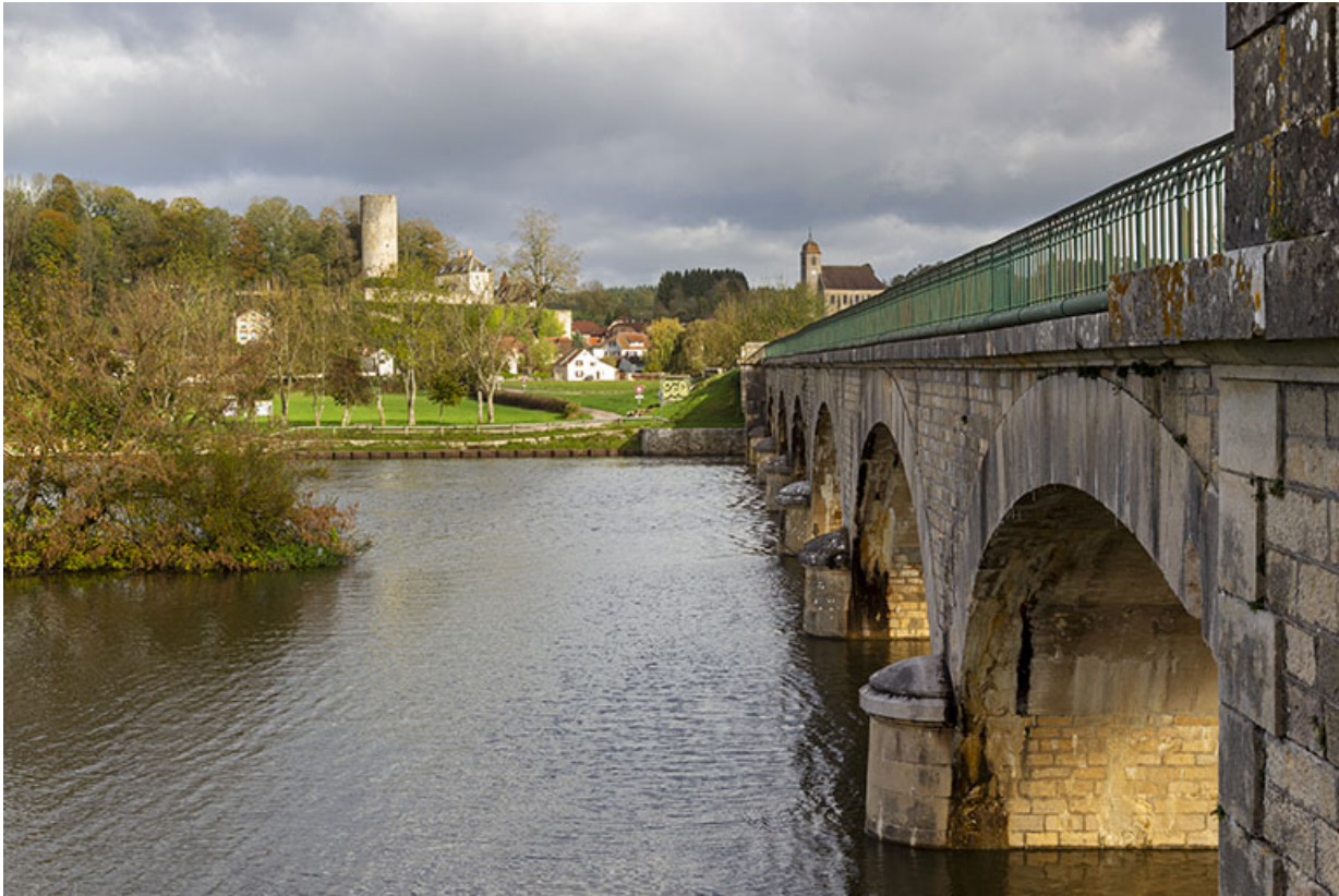
Le pont de chantes et le village de Rupt-sur-Saône. 70, Chantes
