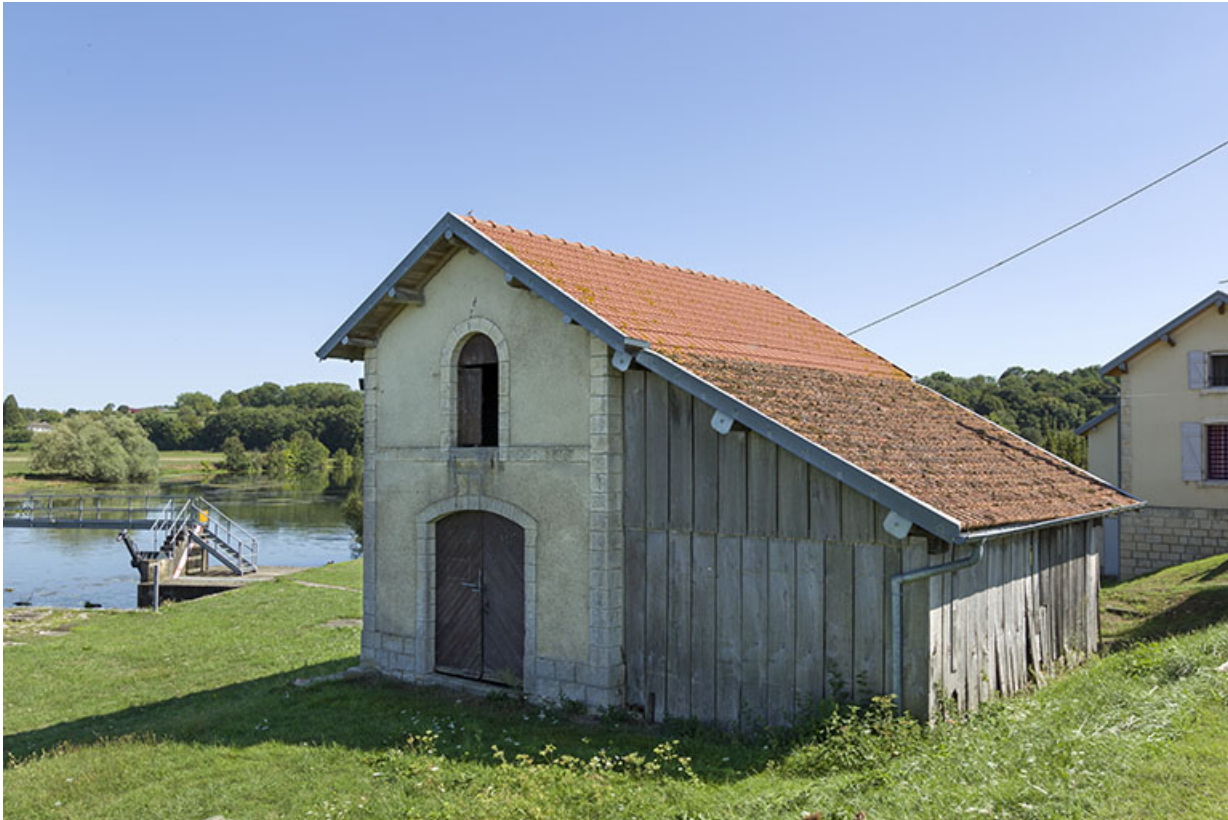
Magasin à aiguilles du barrage. 70, Chantes
