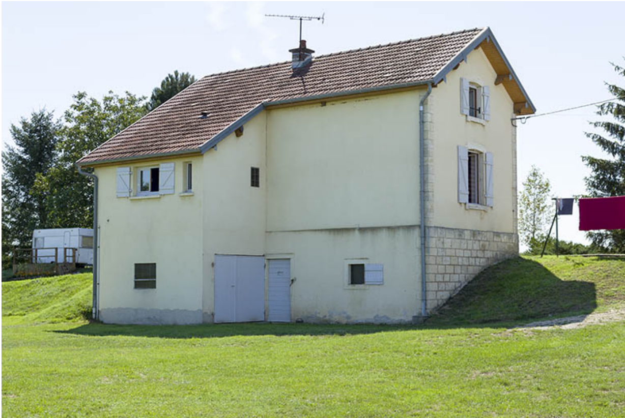
Façade postérieure de la maison.
