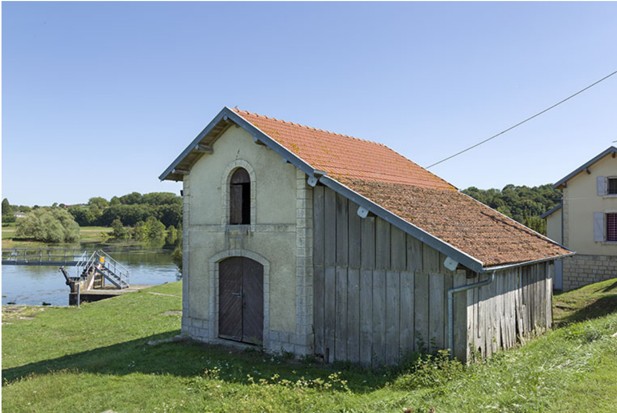
Magasin à aiguilles du barrage. 70, Chantes
