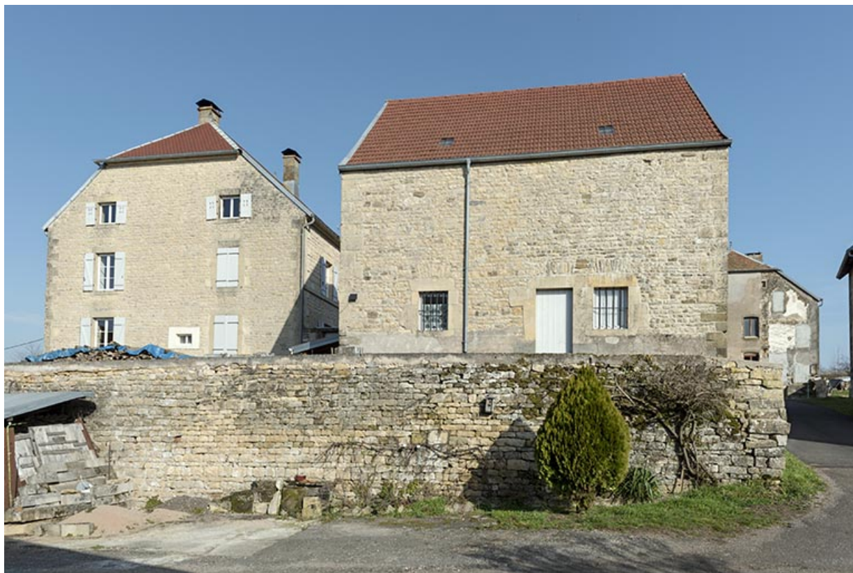
Depuis l'impasse de l'église au sud-ouest, vue de la face postérieure de la dépendance et du pignon occidental de la maison. 70, Cendrecourt, 2 impasse de l'Eglise
