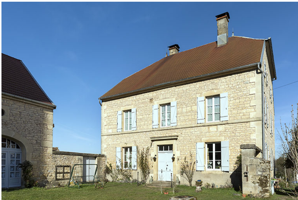
Vue de trois-quart de la façade antérieure et de la cour intérieure.
