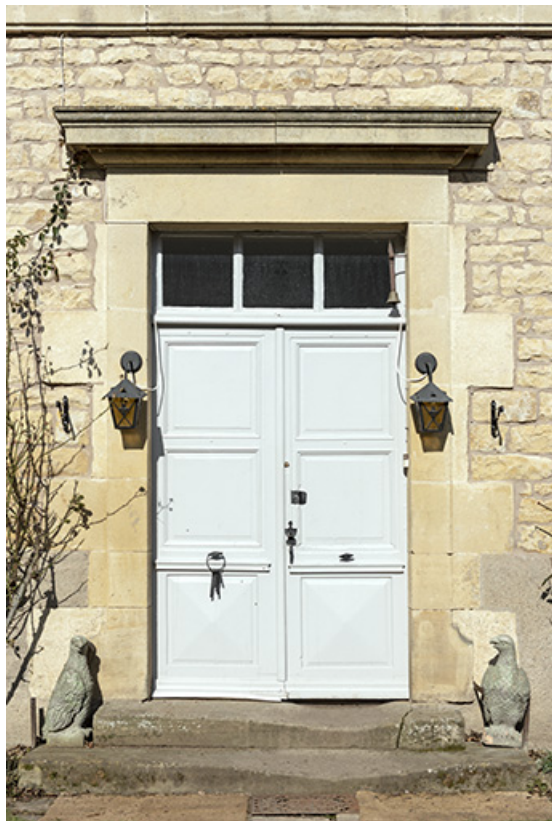
Vue de détail de la porte d'entrée sur la façade antérieure.
