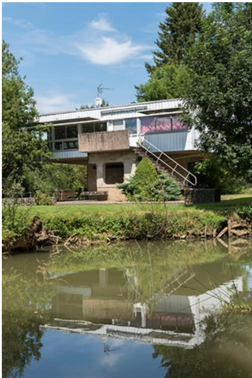
Vue de la villa Kielwasser depuis la rive du village
